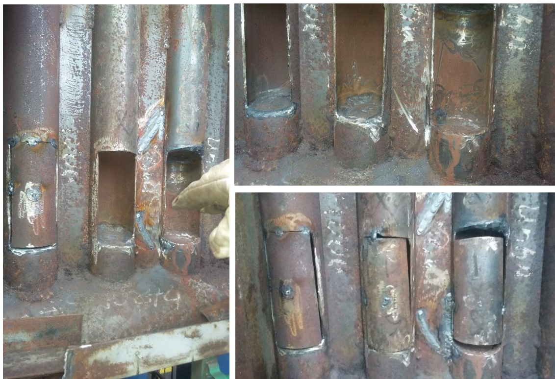
Figura (23) – Tamponagem dos tubos comprometidos da caldeira. (Fonte: autor).
