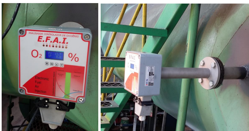
Figura (26) – Analisador/controlador de injeção de O_2 no coletor de gases. (Fonte: autor).
