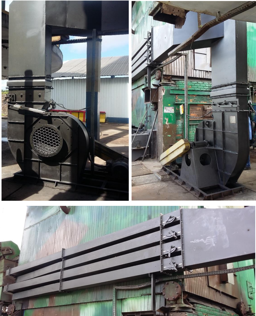
Figura (20) – Nova configuração do sistema de ar secundário da caldeira. (Fonte: autor).
