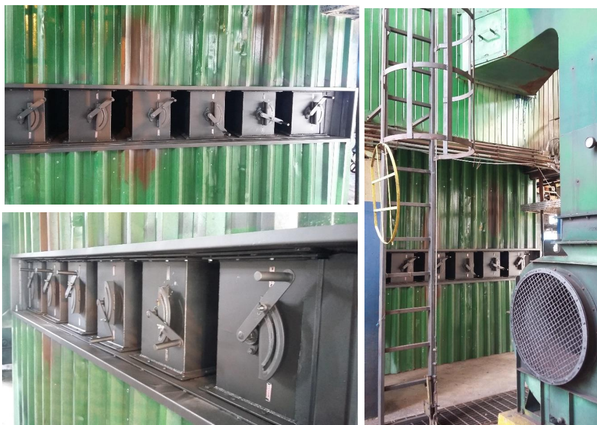
Figura (19) – Configuração do sistema de ar primário da caldeira biomassa. (Fonte: autor).
