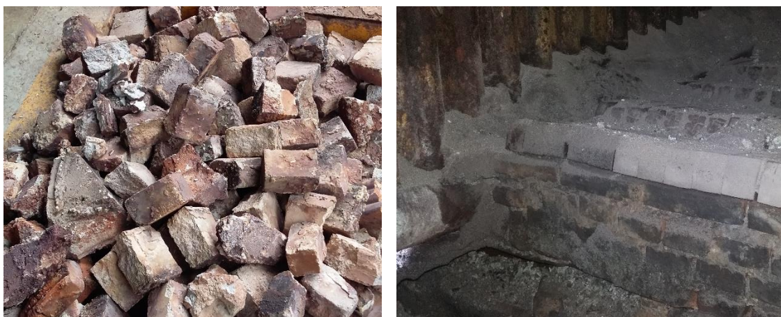
Figura (25) – Refratário substituído do interior da parede traseira (Fonte: autor)
