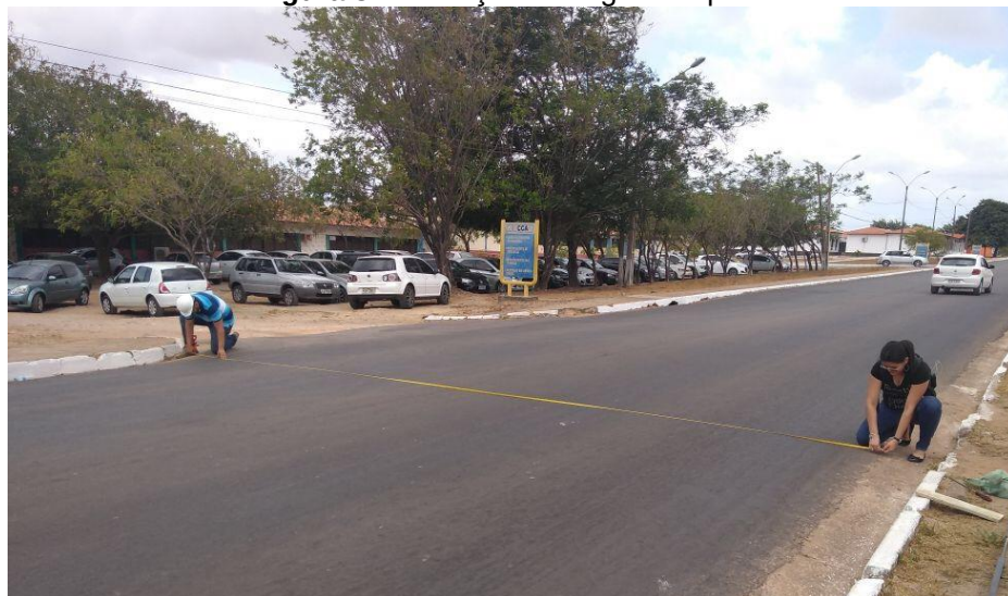
Figura 31 - Medição da largura da pista
