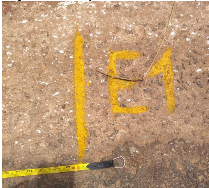
Figura 30 - Demarcação da estaca inicial em campo
