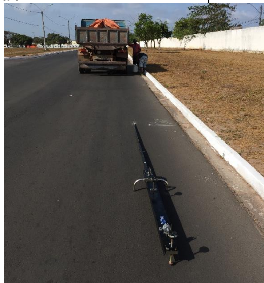
Figura 6 – Deslocamento do caminhão para leitura final
