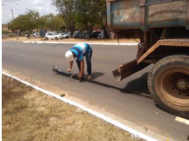
Figura 34 - Posicionamento da viga no pavimento
