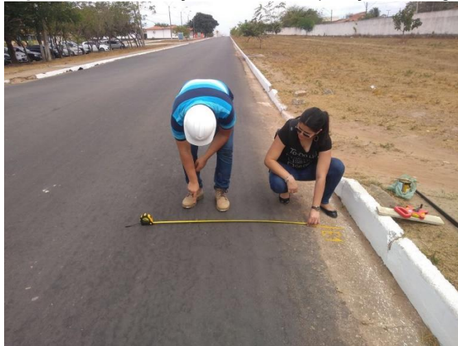
Figura 32 - Demarcação da linha de aplicação da carga
