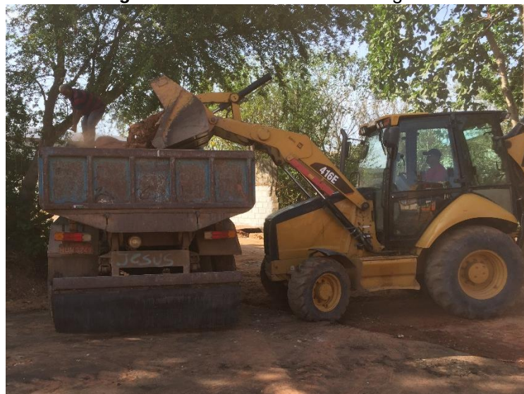
Figura 27 - Caminhão sendo carregado
