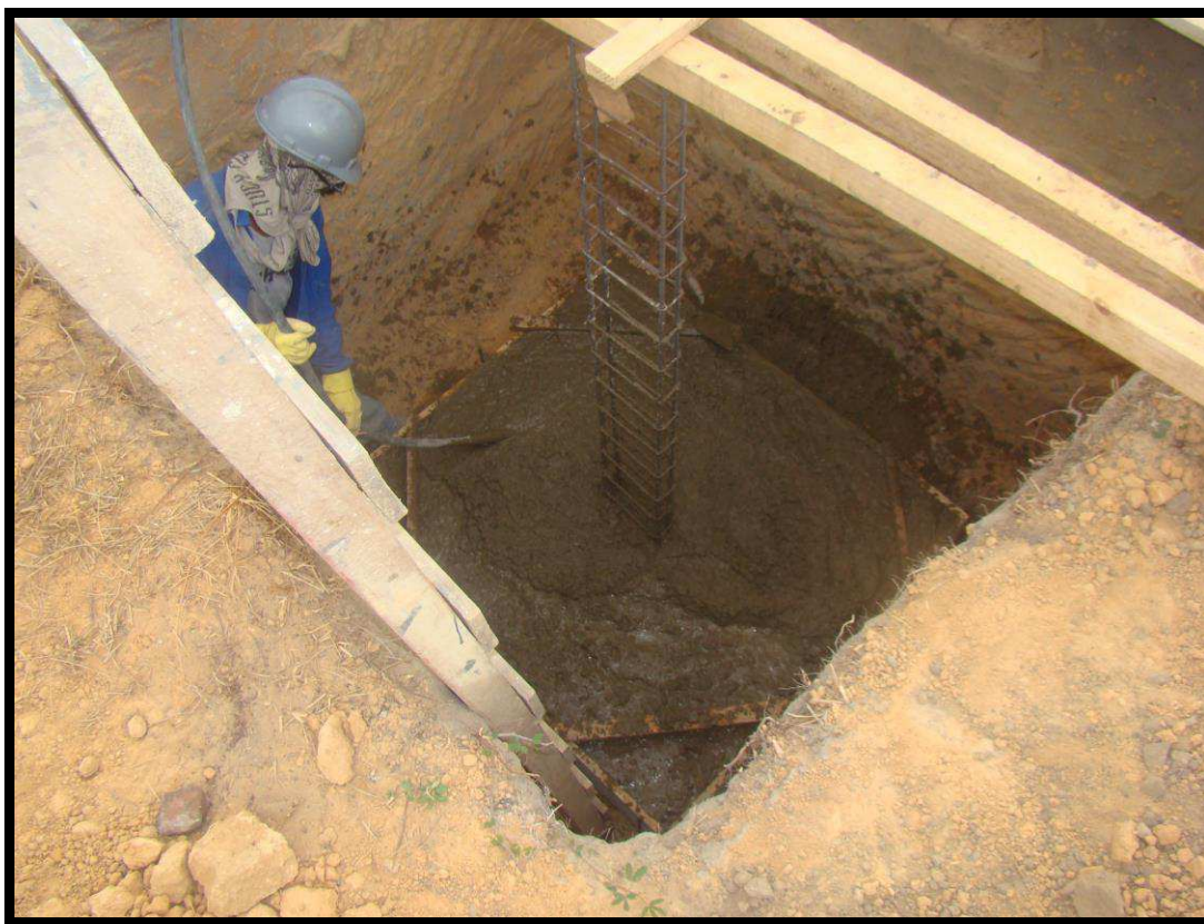
Figura 29 - Concretagem de sapara isolada
