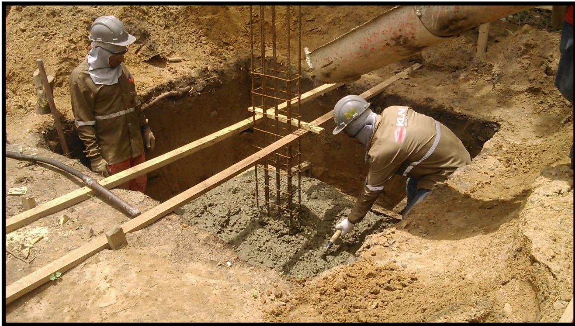
Figura 20 - Concretagem de sapata isolada
