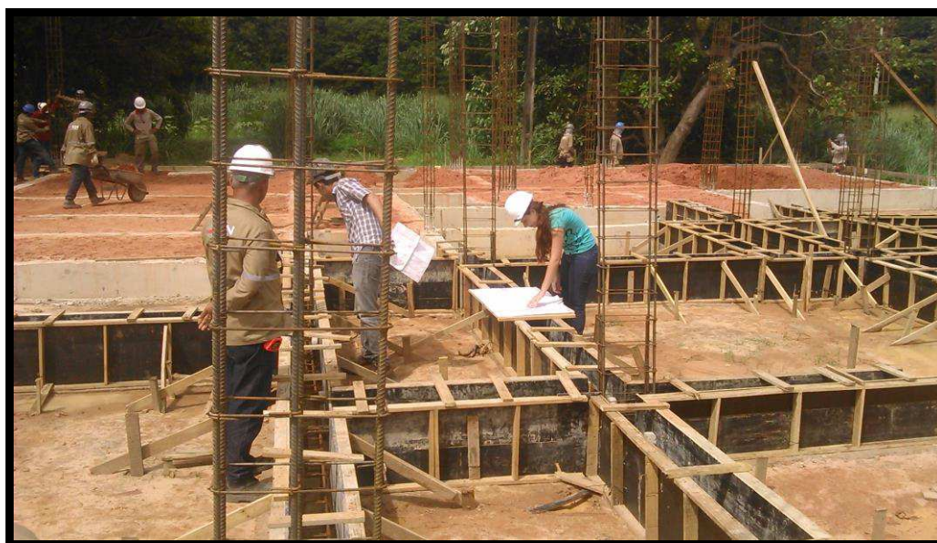
Figura 45 - Armação de pilares e aplicação de formas para vigas de amarração
