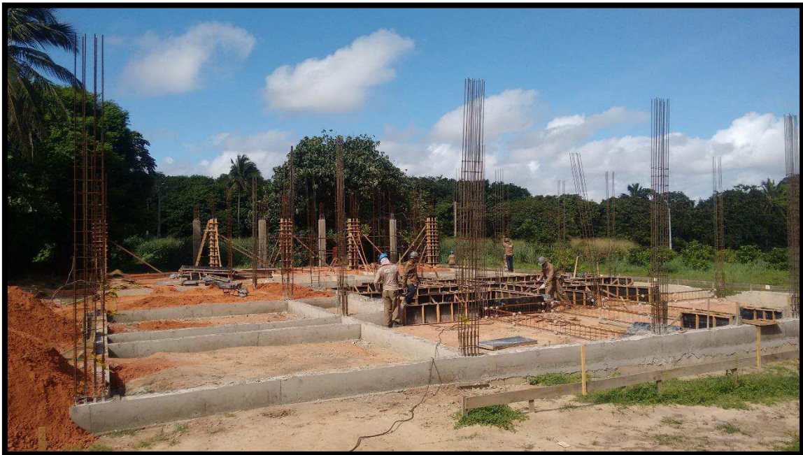
Figura 21 - Armação dos pilares e aplicação de formas
