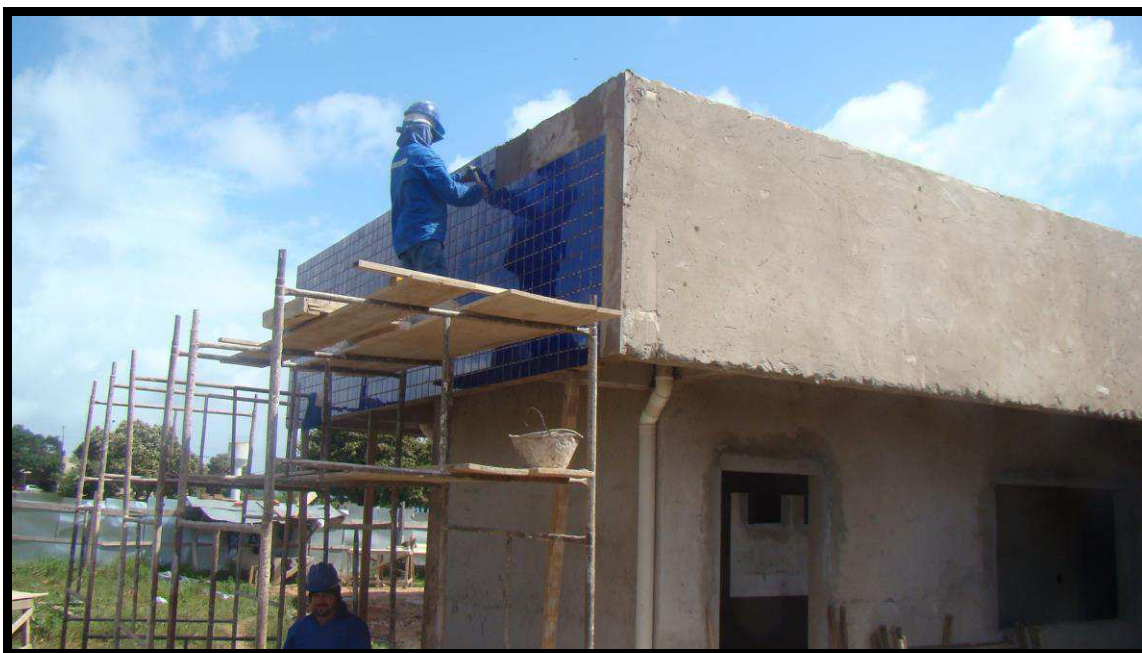
Figura 32 – Aplicação de revestimento cerâmico
