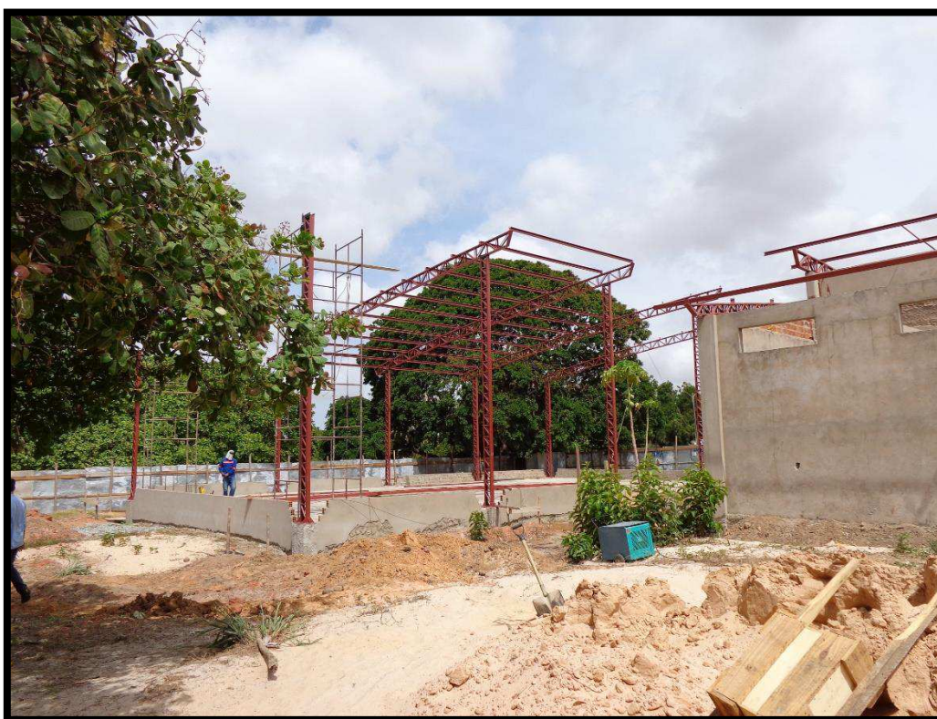
Figura 13 - Construção da estrutura metálica do ginásio
