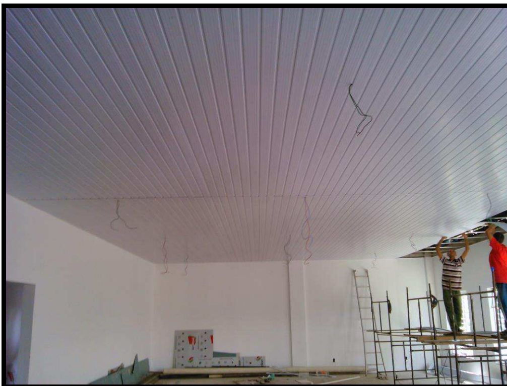
Figura 39 - Aplicação de forro PVC na academia
