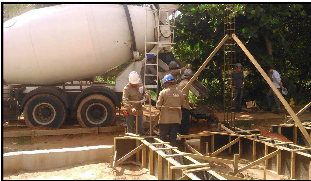
Figura 46 - Recebimento de concreto usinado
