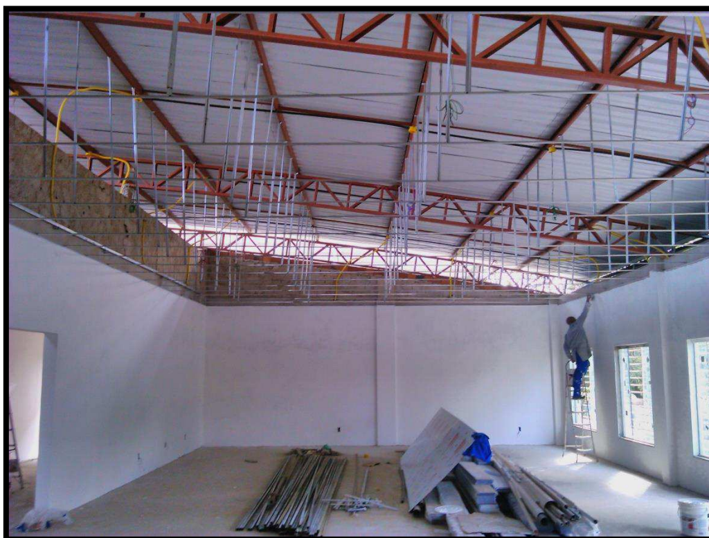
Figura 14 - Aplicação do forro PVC da academia
