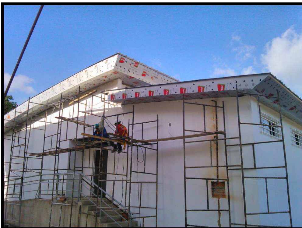
Figura 37 - Instalação da platibanda
