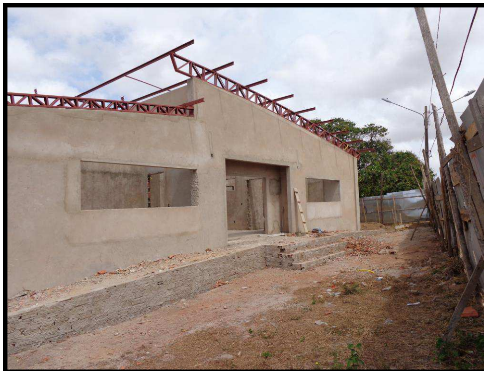
Figura 36 - Instalação de estrutura metálica para cobertura da academia
