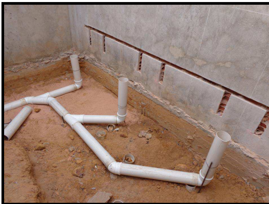
Figura 35 - Instalação dos pontos de esgotamento sanitário
