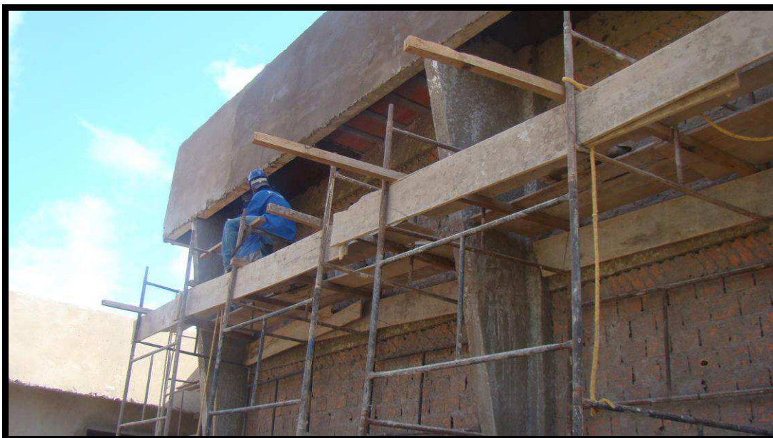
Figura 30 - Aplicação de chapisco nas paredes externas
