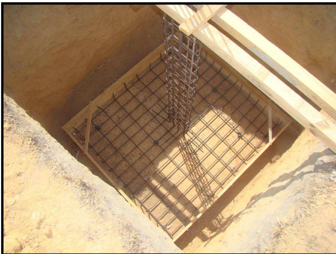
Figura 16 - Colocação da armadura da sapata, para posterior concretagem
