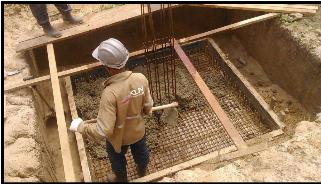
Figura 42 - Detalhe da armadura de sapata isolada
