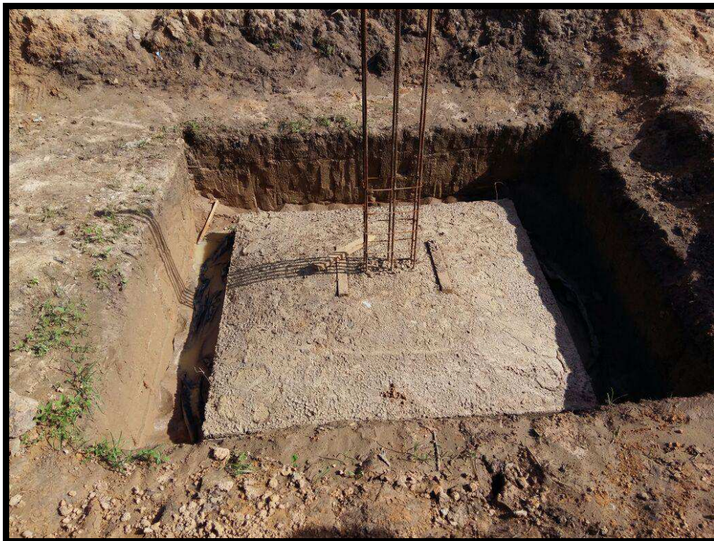
Figura 43 - Sapada isolada concretada
