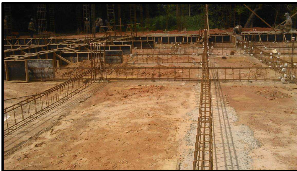
Figura 44 - Aplicação de formas para armadura de vigas de amarração
