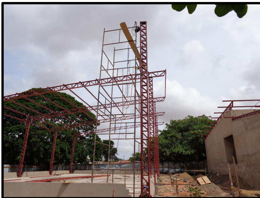
Figura 34 - Instalação da estrutura metálica do ginásio
