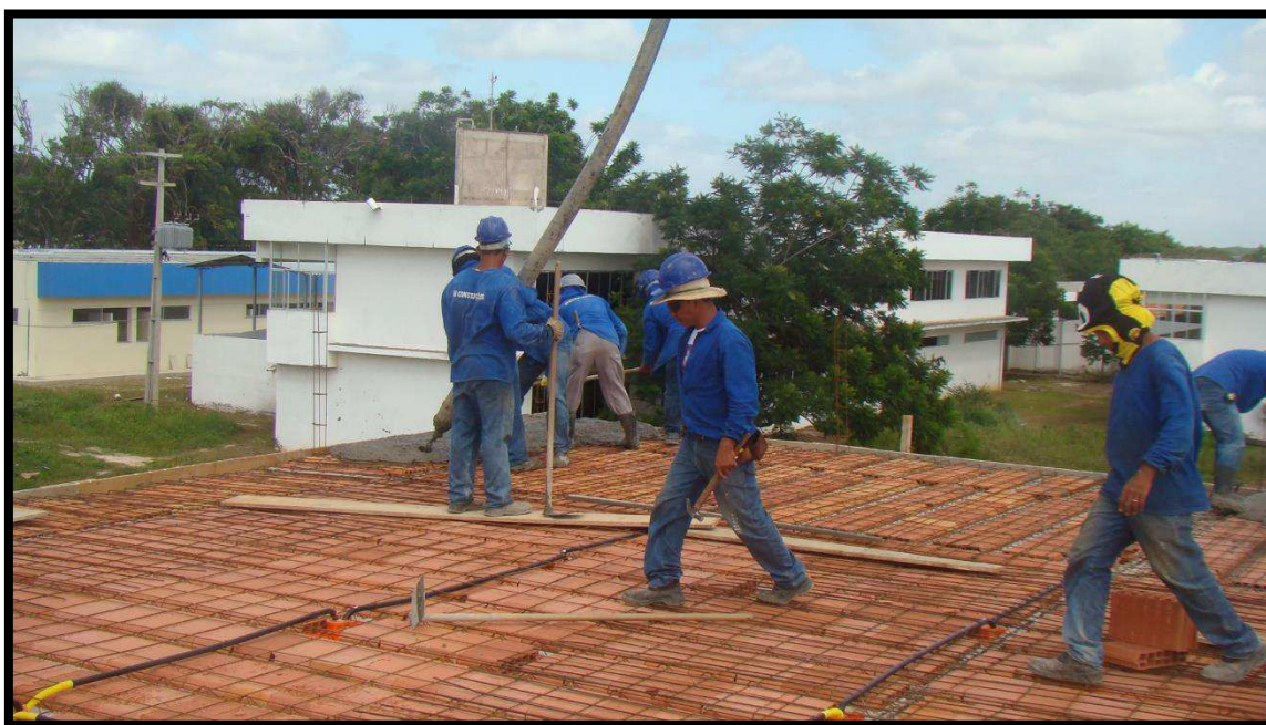
Figura 17 - Concretagem de laje pré-fabricada de tijolos cerâmicos
