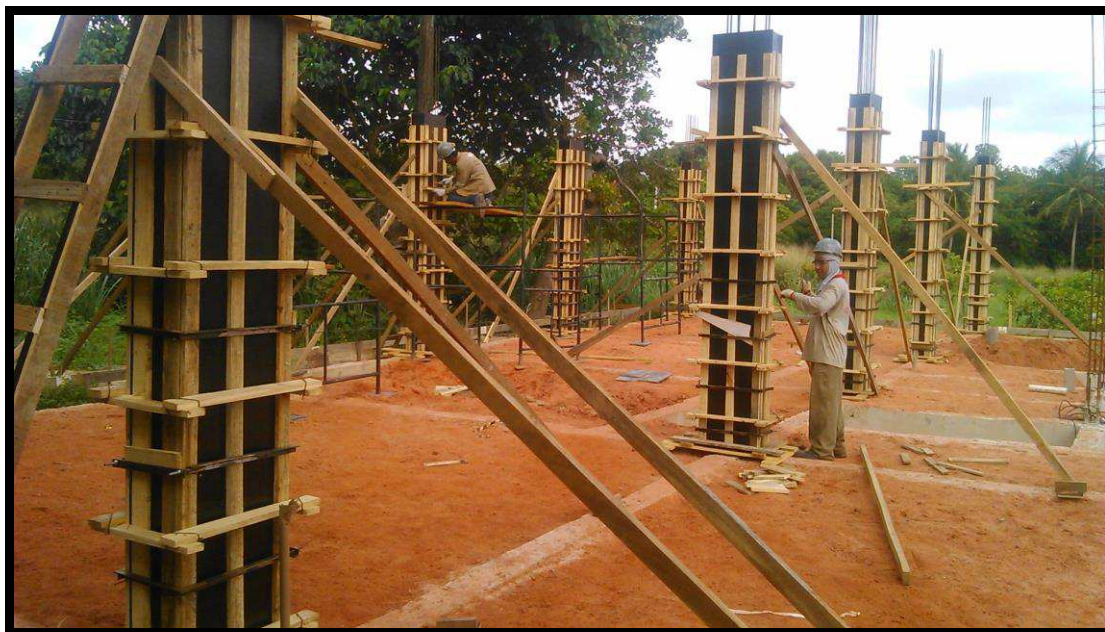
Figura 47 - Moldagem das formas dos pilares
