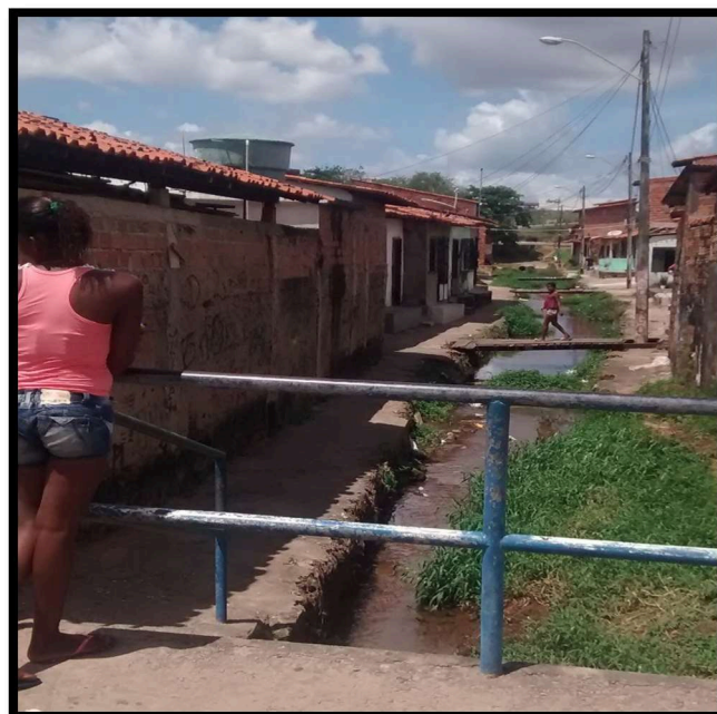
Figura 35: Problemas de poluição no canal do Bairro Barreto, São Luís – MA.
