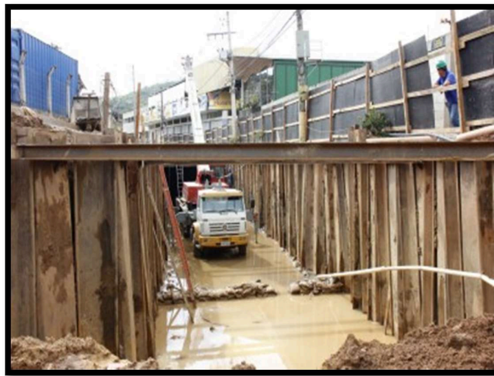
Figura 8: Canalização do córrego dos Afonsos, no distrito de Conselheiro Paulino do município de Nova Friburgo.
