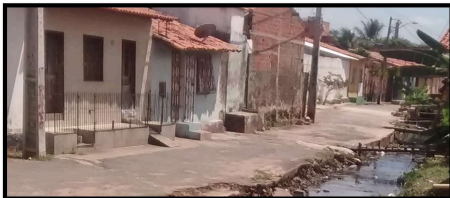
Figura 33: Níveis de Soleiras na Rua Renato Nunes, Bairro Barreto, São Luís – MA.
