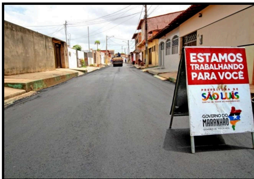
Figura 17: Obras de pavimentação urbana no bairro Cidade Operária, São Luís – MA.
