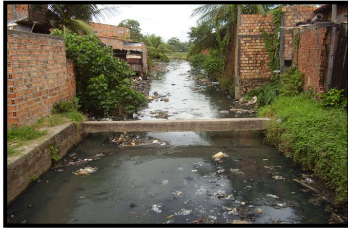
Figura 10: Ocupação nas margens do Canal do Coroadó.
