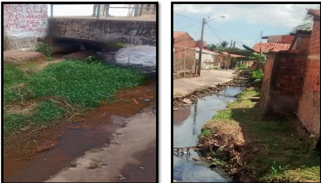
Figura 37 e 38: Descarga de esgoto no canal do Bairro Barreto, São Luís – MA.
