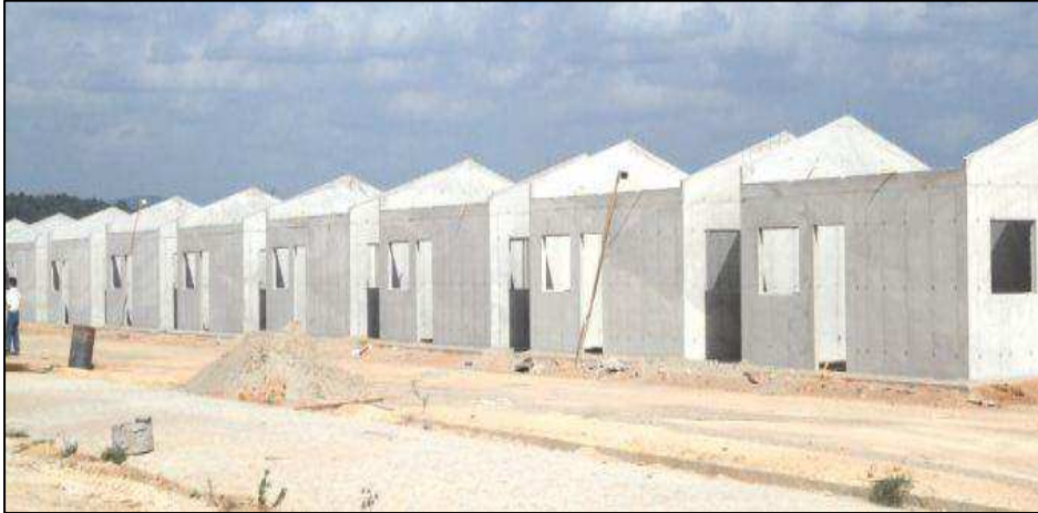
Figura 5 - Sistema construtivo com concreto de baixa densidade (concreto celular).
