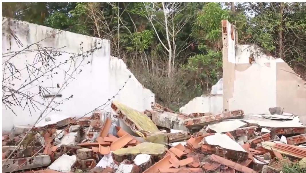
Imagem 4 - Casa demolida no território Cajueiro
