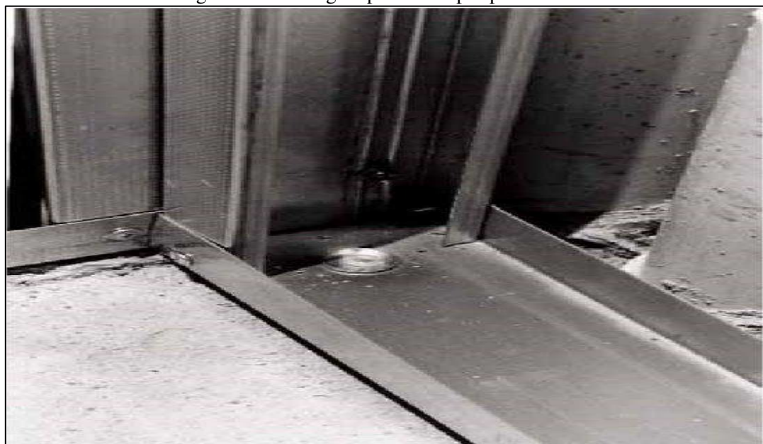
Imagem 8 - Ancoragem provisória por pinos fincados
