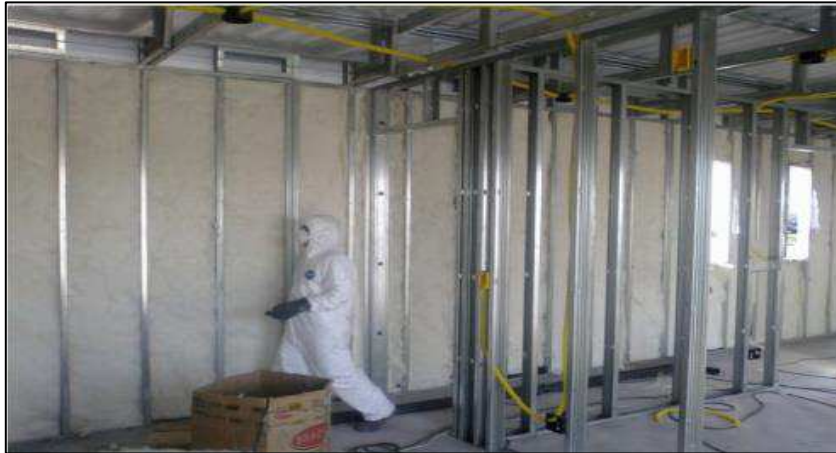
Imagem 10 – Isolamento termo-acustico em estrutura de Light Steel Framing .
