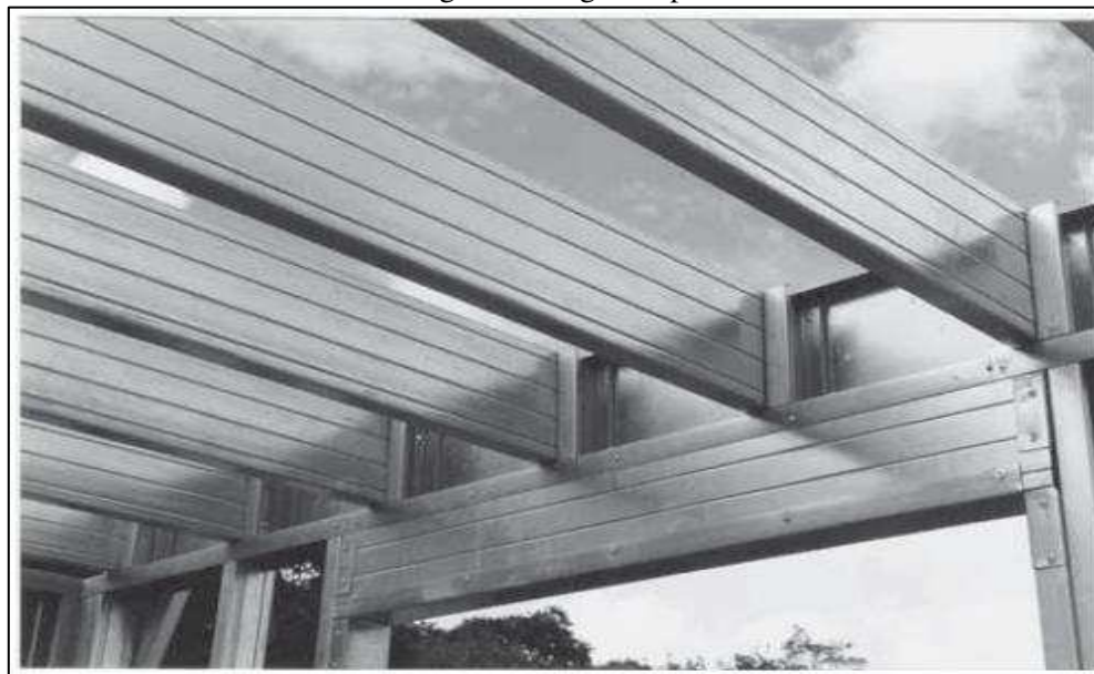
Imagem 9 - Vigas de piso
