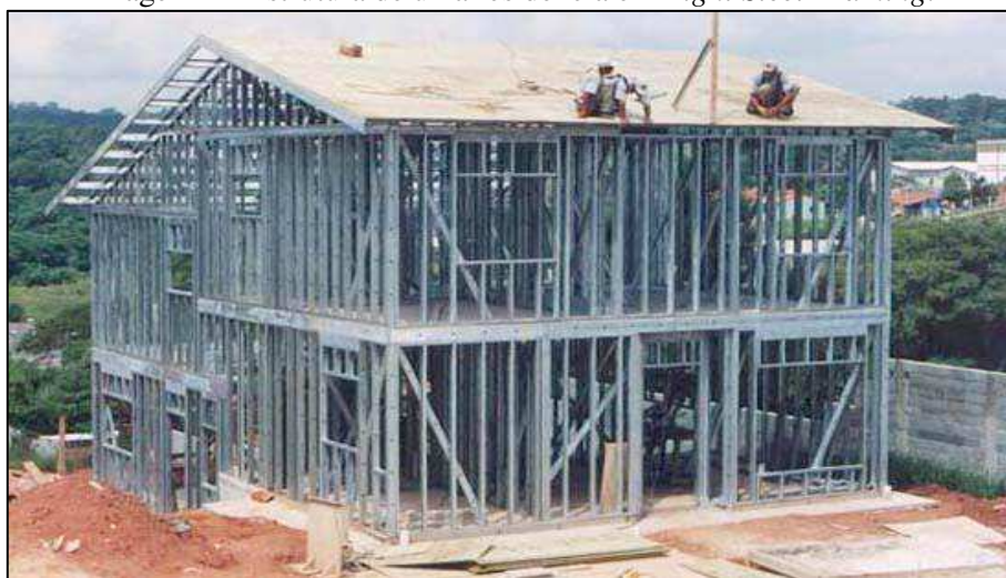
Imagem 4 - Estrutura de uma residência em Light Steel Framing .
