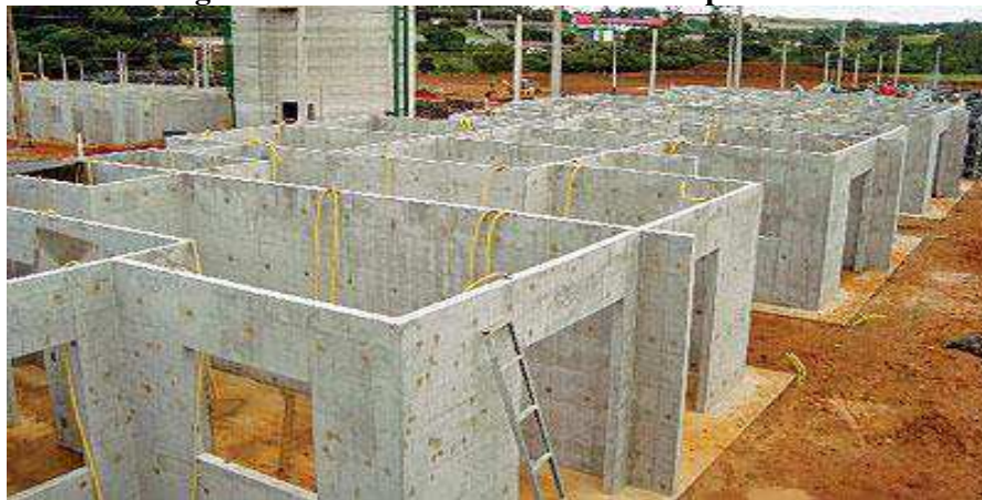
Imagem 2 - Sistema de concreto armado por fôrmas
