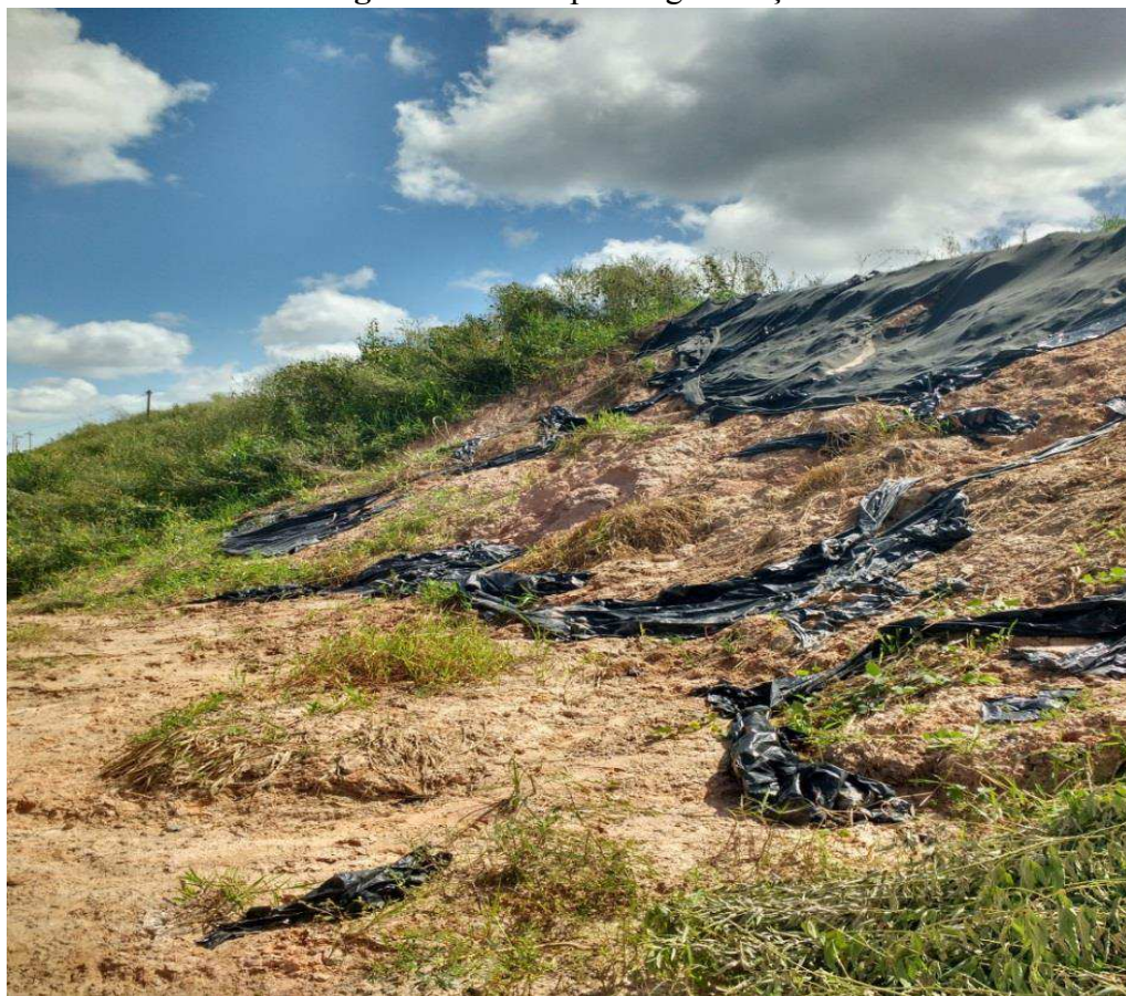
Figura 37: Área para regularização
