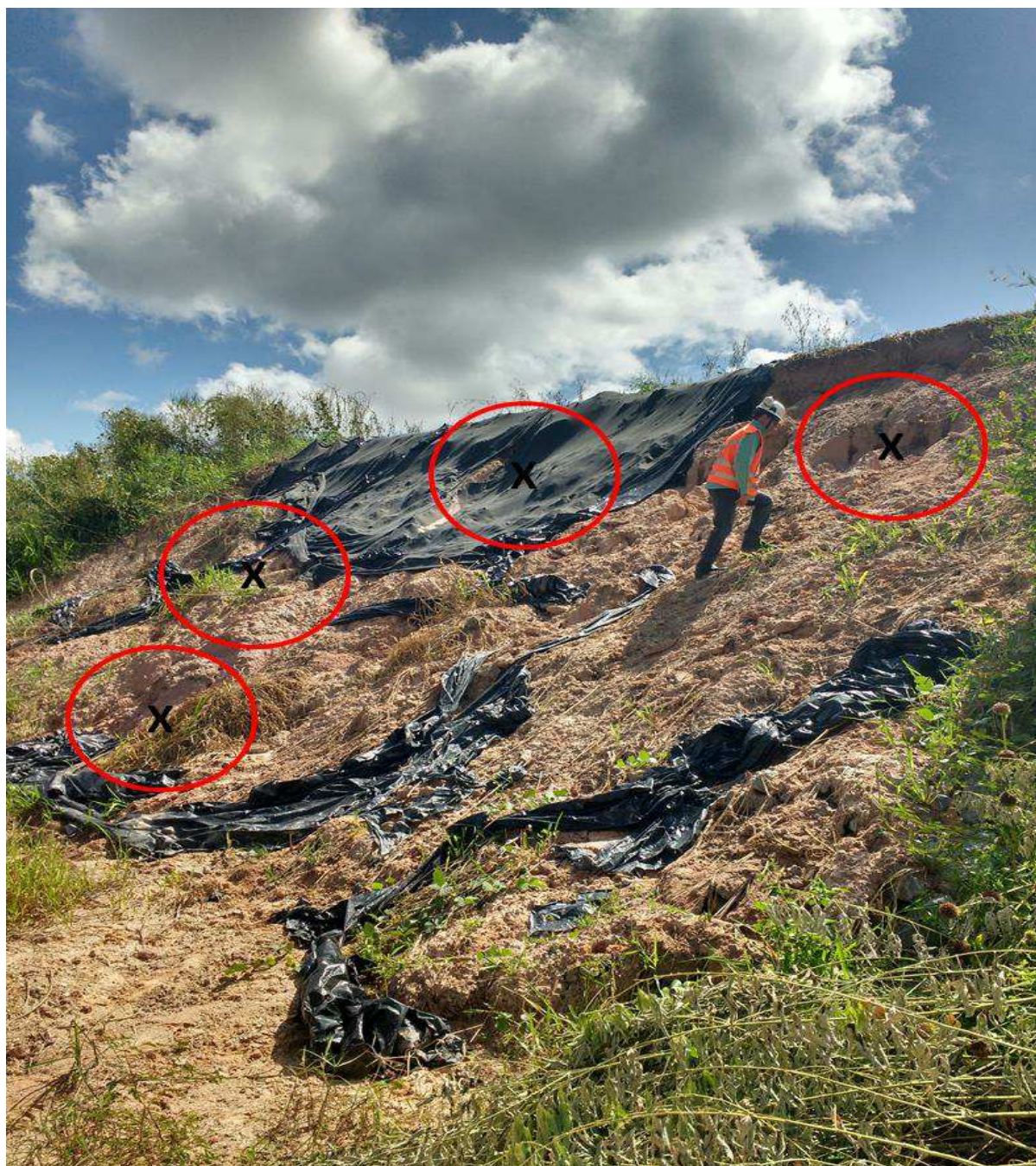
Figura 34: Vista do pé do aterro
