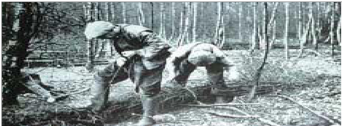
Figura 23: Europa em 1900 com trabalhadores utilizando vegetação para aplicação de técnicas bioengenharia de solos
