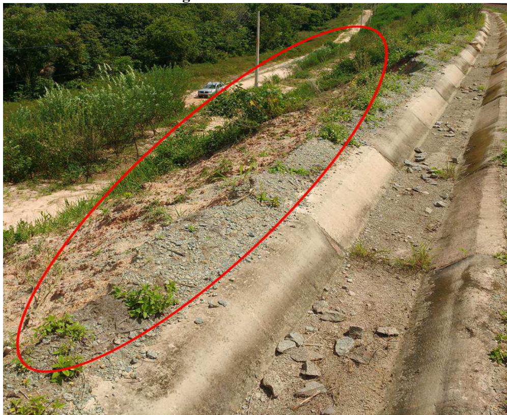
Figura 35: Crista do talude
