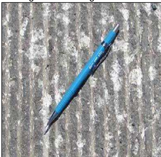
Figura 7 - Fresagem Padrão.
