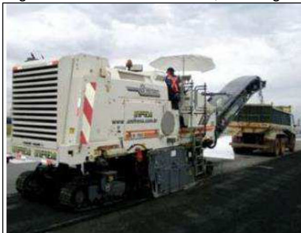
Figura 12 - Fresadora W 1900, da Wirtgen.
