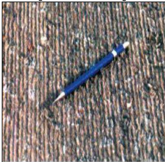
Figura 9 - Microfresagem
