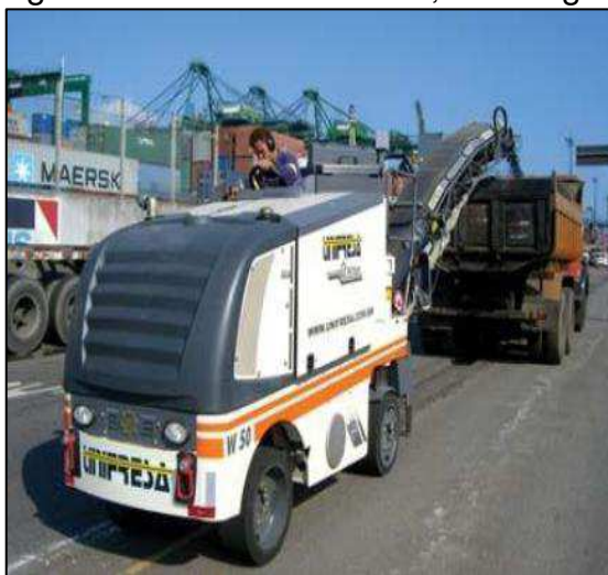
Figura 10 - Fresadora W 50, da Wirtgen.
