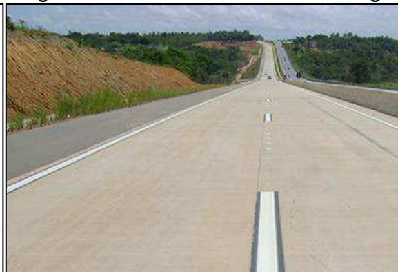
Figura 2 - Estrutura de Pavimento Rígido Figura 3 - Rodovia de Pavimento Rígido
