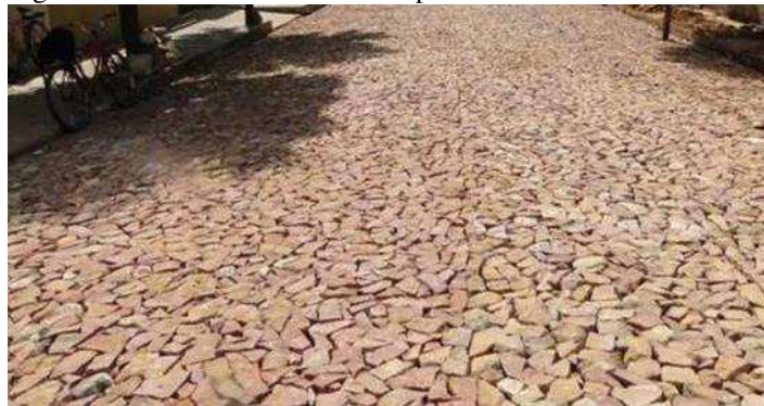
Figura 7 – Pavimento de alvenaria poliédrica
