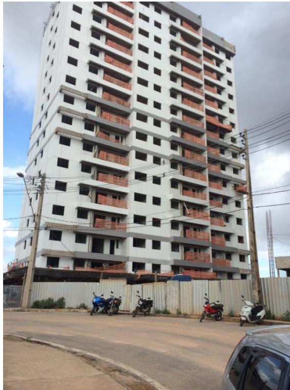
Figura 15 – Obra Ilha Parque Residence em etapa de execução
