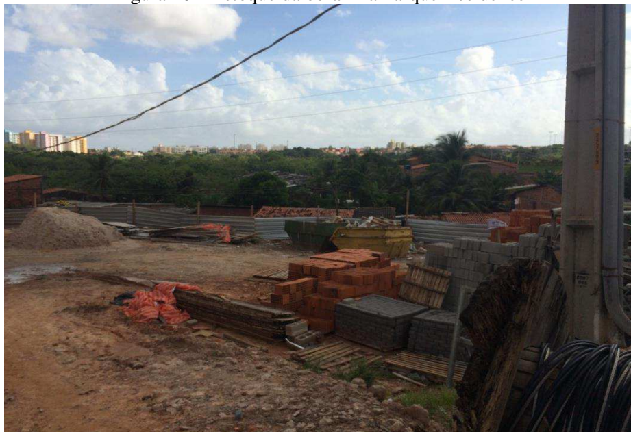
Figura 16 – Estoque da obra Ilha Parque Residence
