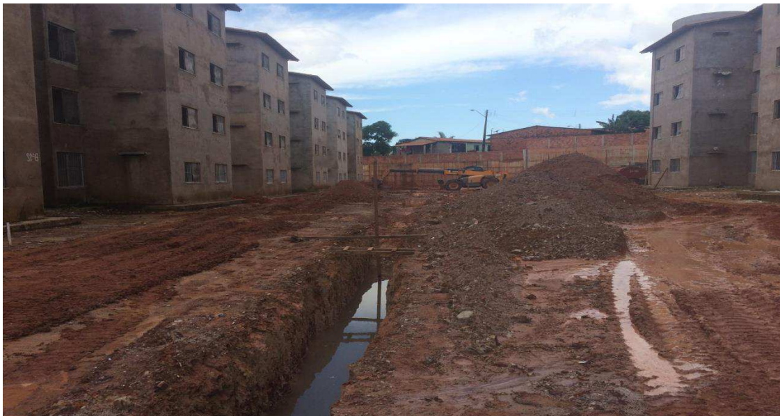
Figura 14 – Execução do sistema de esgoto
