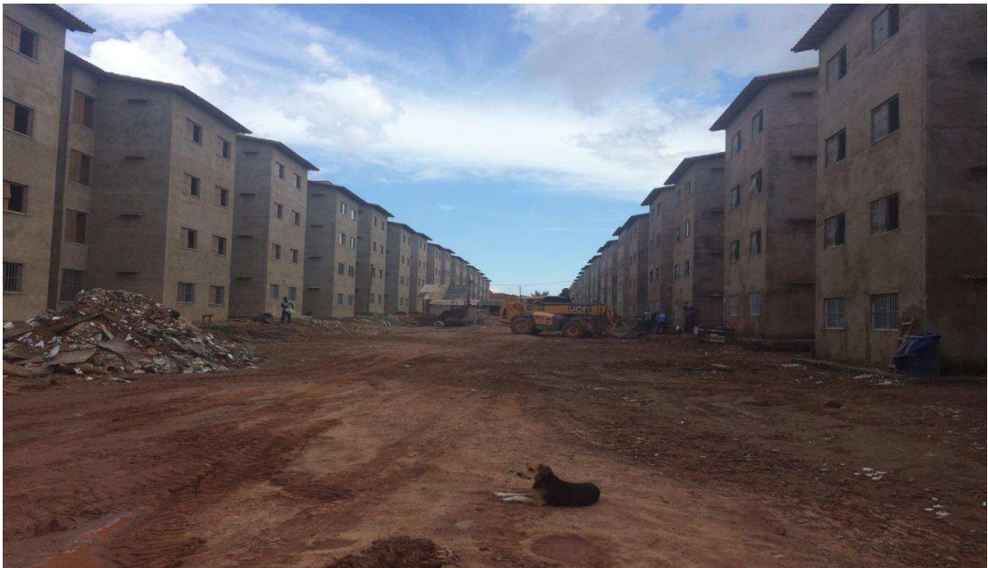
Figura 13 – Obra Piancó Paraíso em etapa de execução
