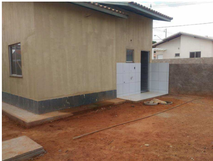
Figura 12 - Fachada Posterior da Unidade Residencial em Estudo
