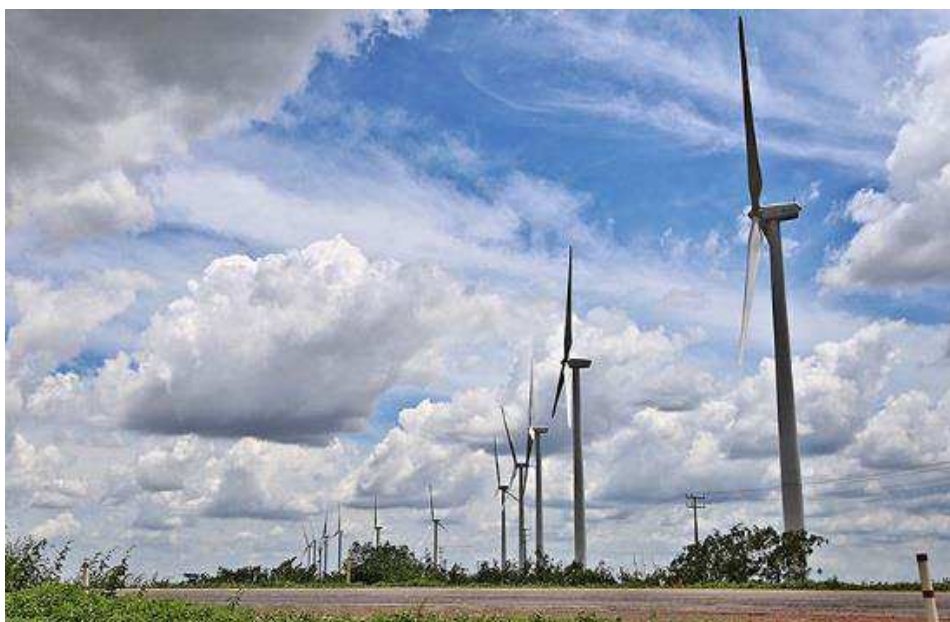
Figura 3 – Complexo eólico chapada do Piauí. (Fonte: Repositório da Queiroz Galvão Energia) 1
