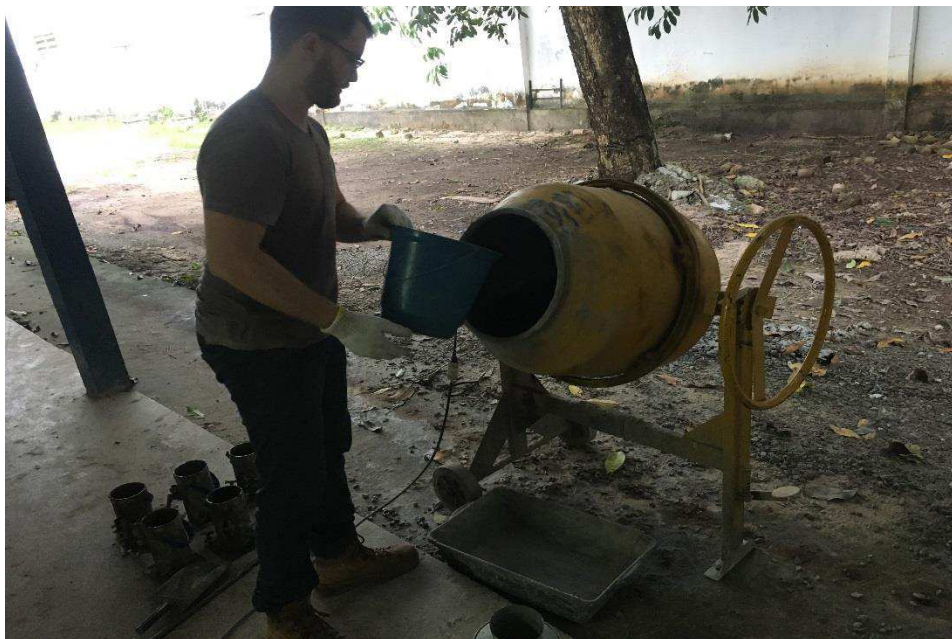
Foto 6 – Preparação do concreto (Fonte: acervo do autor )
