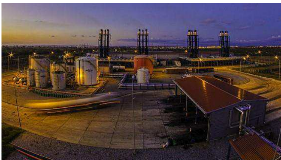
Figura 5 – Usina termelétrica de Campina Grande. (Fonte: Repositório da Borborema Energética) 3
