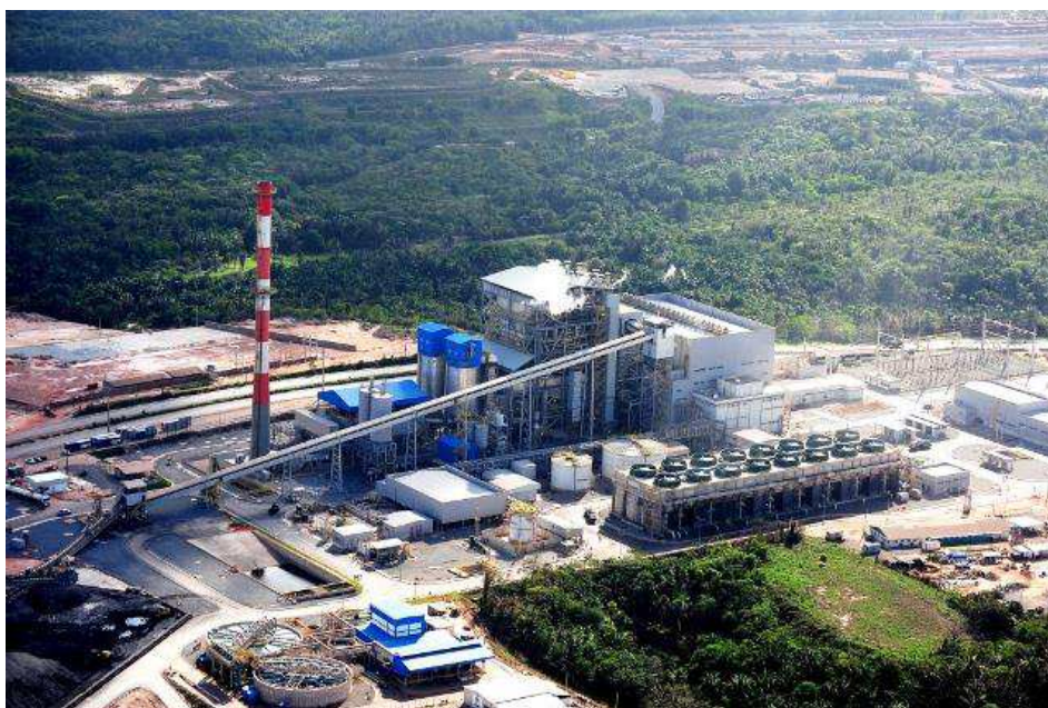
Figura 6 – Usina termelétrica ENEVA em São Luís. (Fonte: Repositório ENEVA – Itaqui) 4
