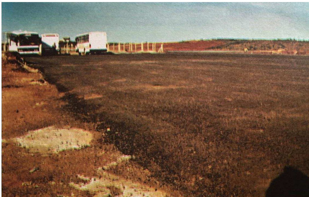
Figura 8 – Pátio de estacionamento com base de cinzas no município de Candiota – RS. (Fonte: Repositório CIENTEC) 6
