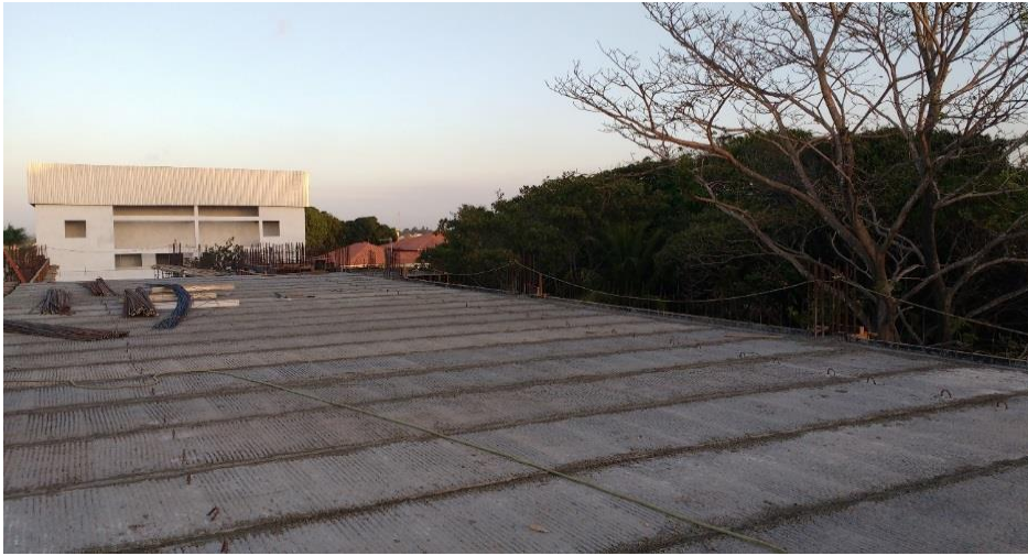
Figura 30 – Lajes pré-fabricadas de concreto vistas por cima.
