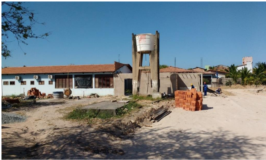
Figura 20 – Vista da primeira edificação onde está sendo realizada reforma.
