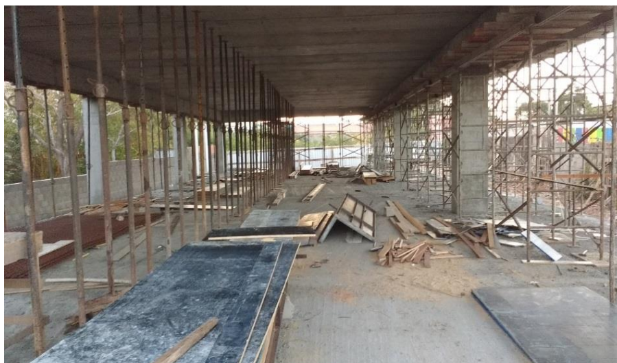
Figura 29 – Lajes pré-fabricadas de concreto vistas por baixo.
