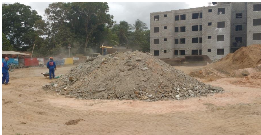
Figura 35 – Disposição dos resíduos da obra.
