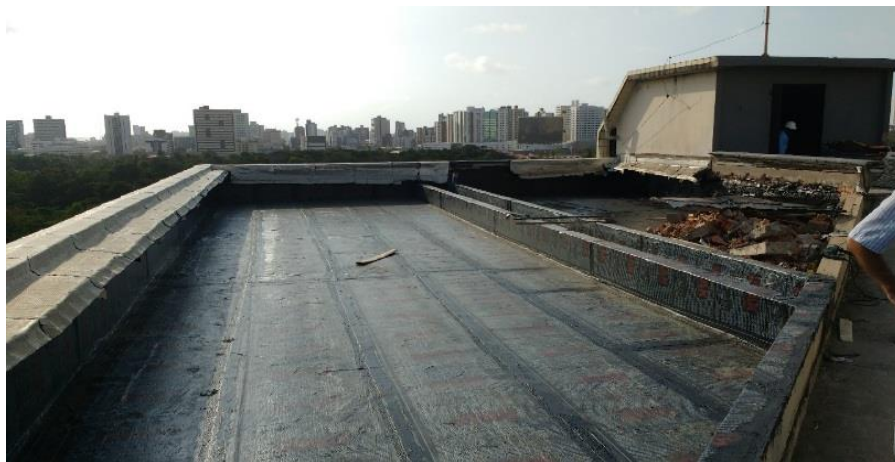
Figura 31 – Vista geral da cobertura onde está sendo feita a manutenção.
