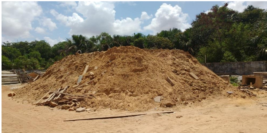
Figura 17 – Disposição dos resíduos sólidos da obra em geral esperando pela coleta e transporte da empresa terceirizada
