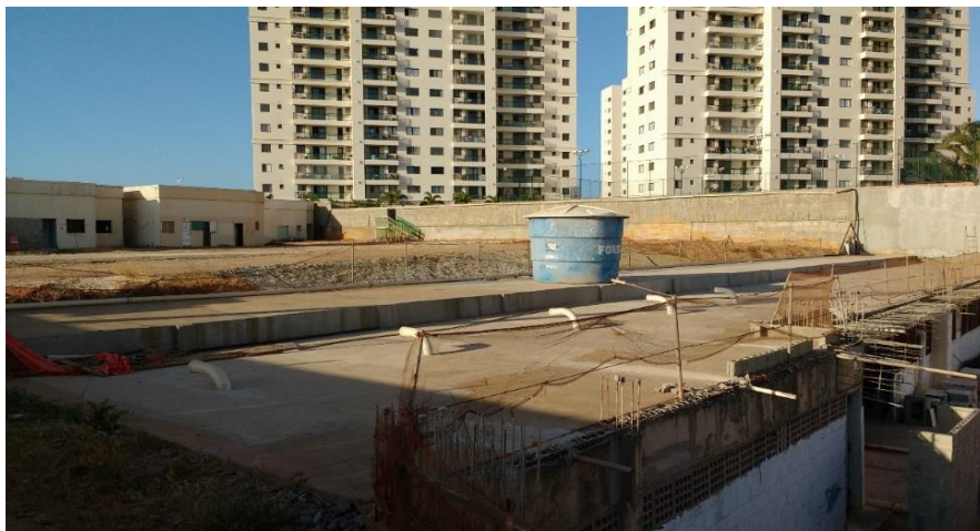
Figura 26 – Vista geral da obra.
