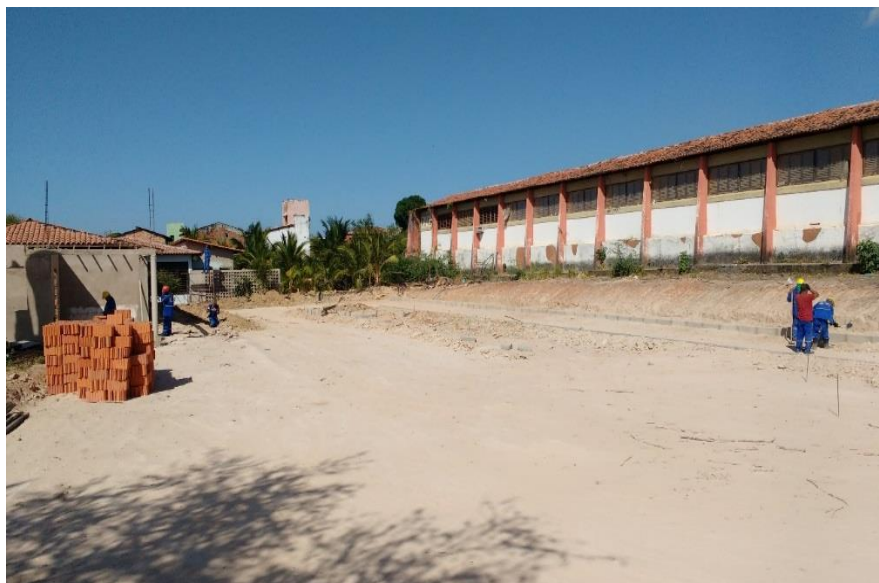
Figura 21 – Vista da segunda edificação onde está sendo realizada reforma.
