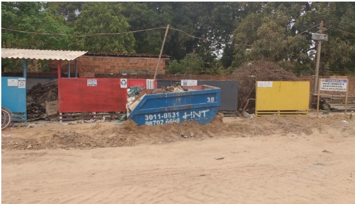
Figura 10 – Segregação dos resíduos em obra visitada
