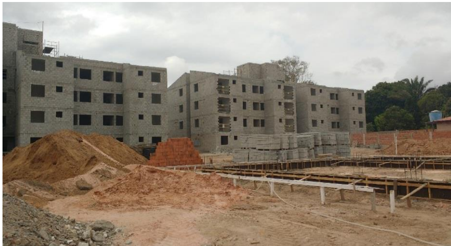
Figura 34 – Visão geral da obra.
