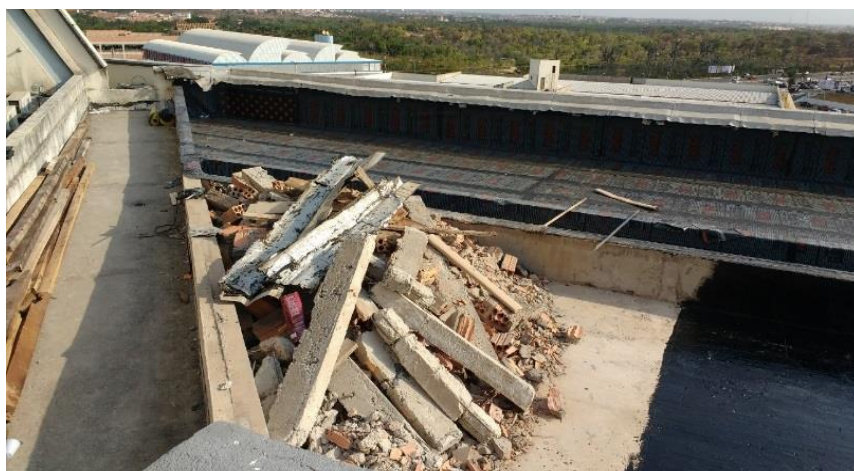
Figura 32 – Disposição dos resíduos da obra.
