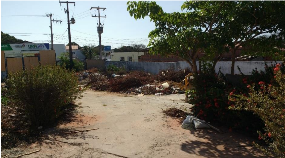
Figura 13 – Resíduos de diferentes classes misturados em obra visitada
