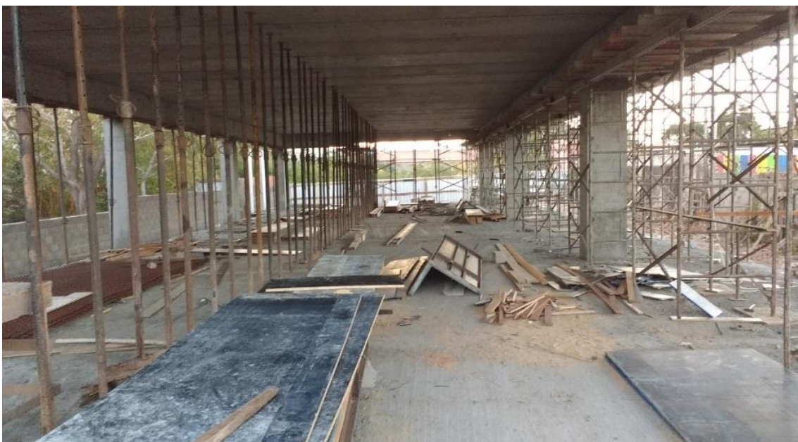
Figura 9 – Construção composta por lajes pré-fabricadas
