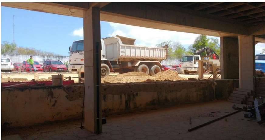
Figura 18 – Transportadora terceirizada realizando a coleta dos resíduos
