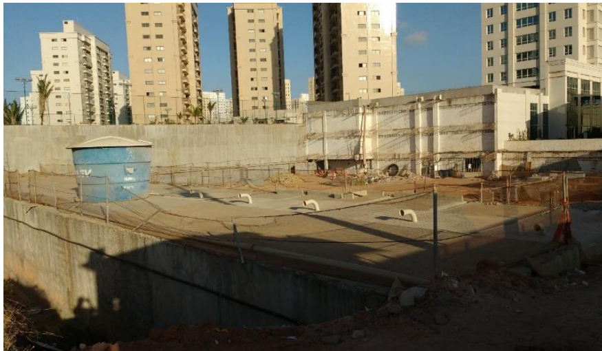
Figura 25 – Vista geral da obra.
