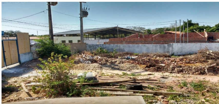
Figura 24 – Disposição dos resíduos da reforma próximo ao portão de saída aguardando a empresa de coleta e transporte.
