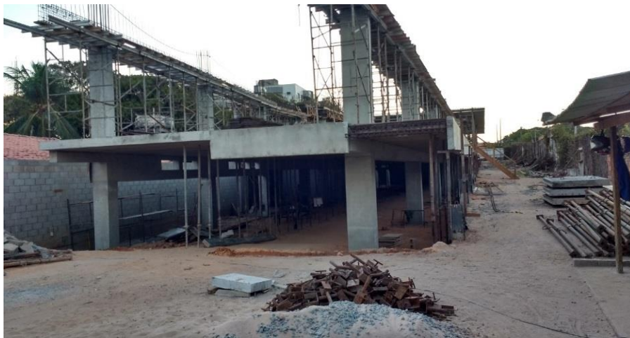
Figura 28 – Vista geral da obra.
