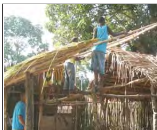
Foto 6. Casa sendo construída Autora: LIMA, A.N., 2008
