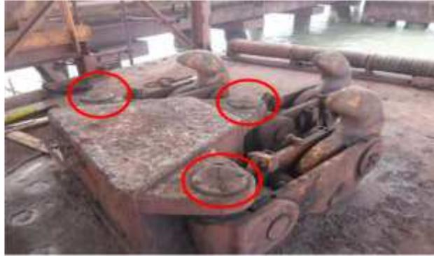
Figura 10 – Corrosão do pino
