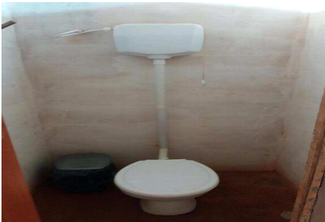
Figura 11- Sanitário do Canteiro de Obra B
