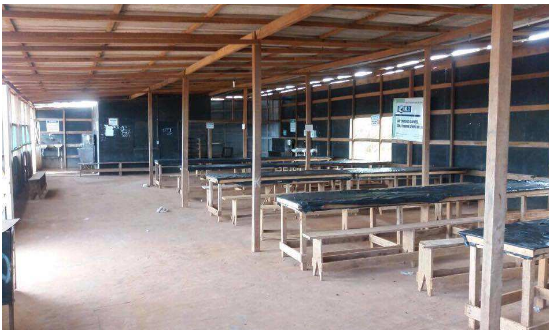
Figura 10 – Refeitório do Canteiro de Obra A
