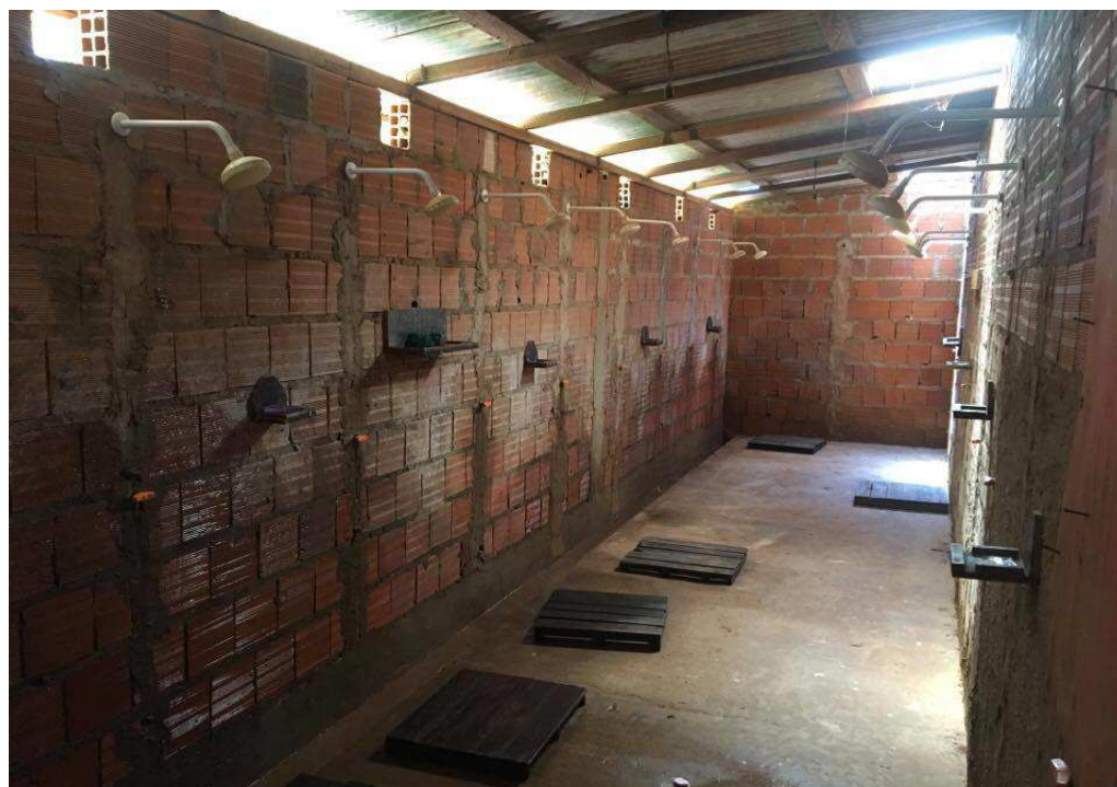
Figura 7 – Área dos chuveiros do Canteiro de obra A
