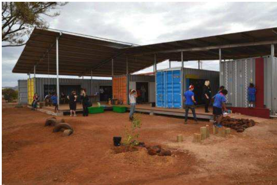
Figura 3 – Canteiro de obra feito com container
