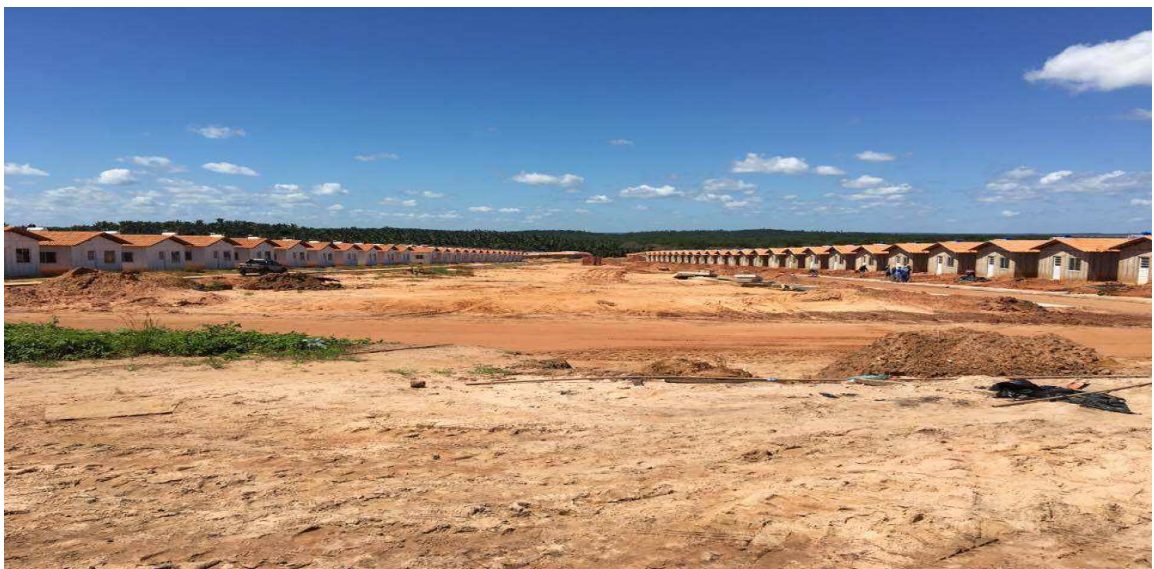
Figura 4 – Vista frontal de uma das vias da obra.
