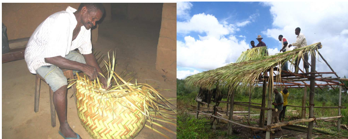
Figura 6: Morador confeccionando cofo e trabalho coletivo usando palha de babaçu para cobertura de um barracão.
