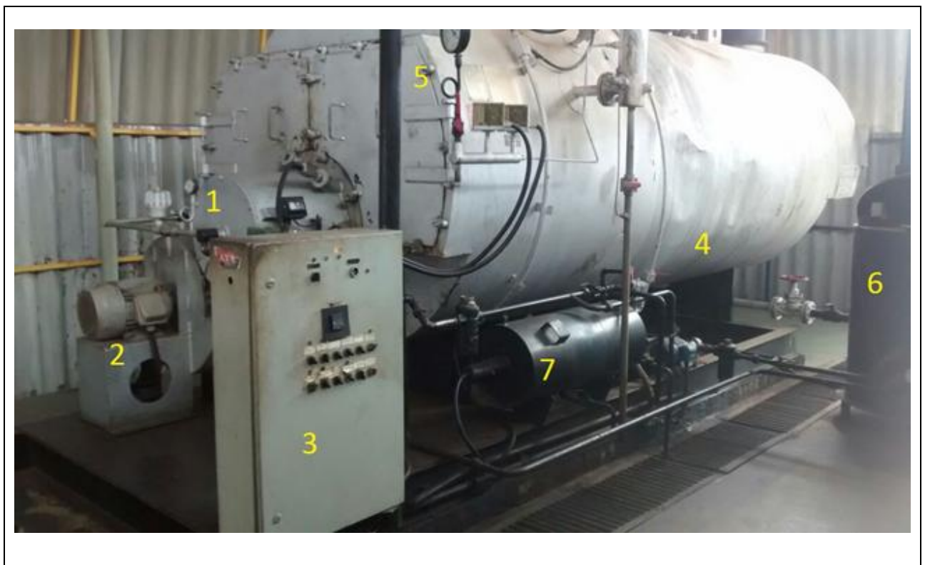
Figura 22. Situação atual da caldeira.
