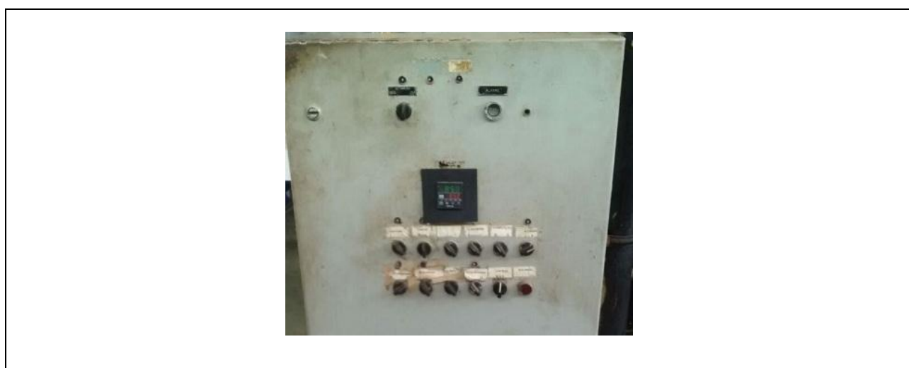
Figura 31. Interface de acionamento do antigo painel.
