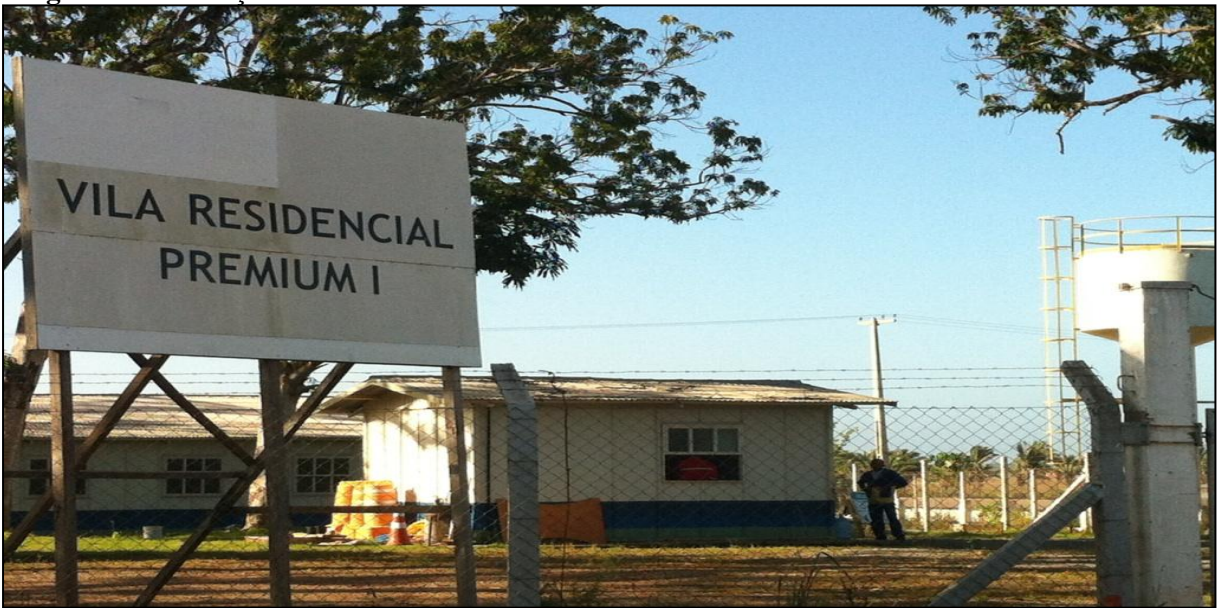
Figura 4 – Instalações existentes das obras iniciais da Refinaria Premium I – Bacabeira – MA.
