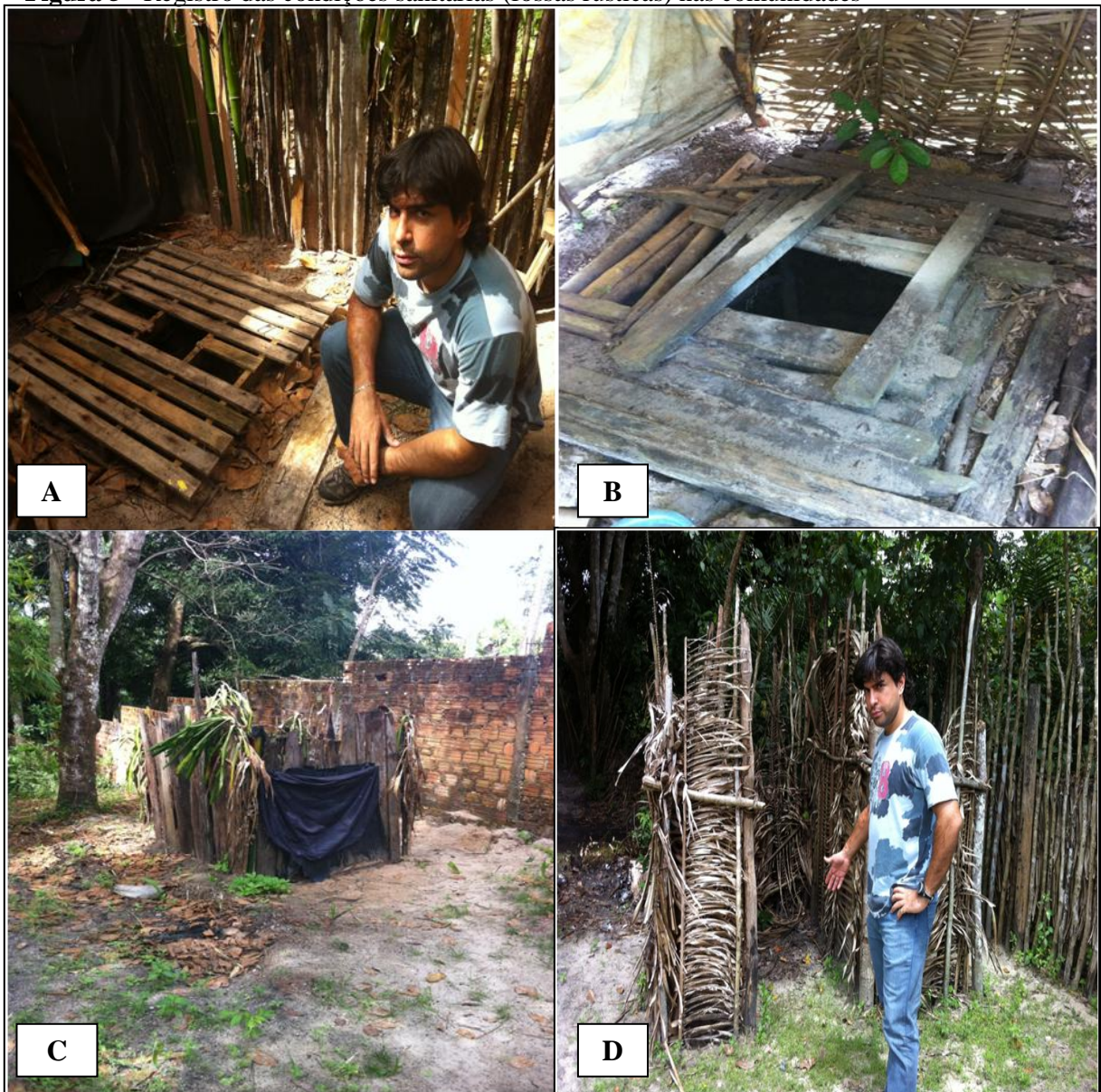
Figura 5 - Registro das condições sanitárias (fossas rústicas) nas comunidades
