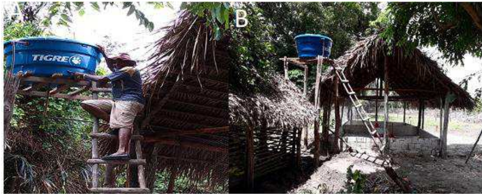
Figura 6 - A e B Implantação do reservatório de água (Instalação hidráulica).
