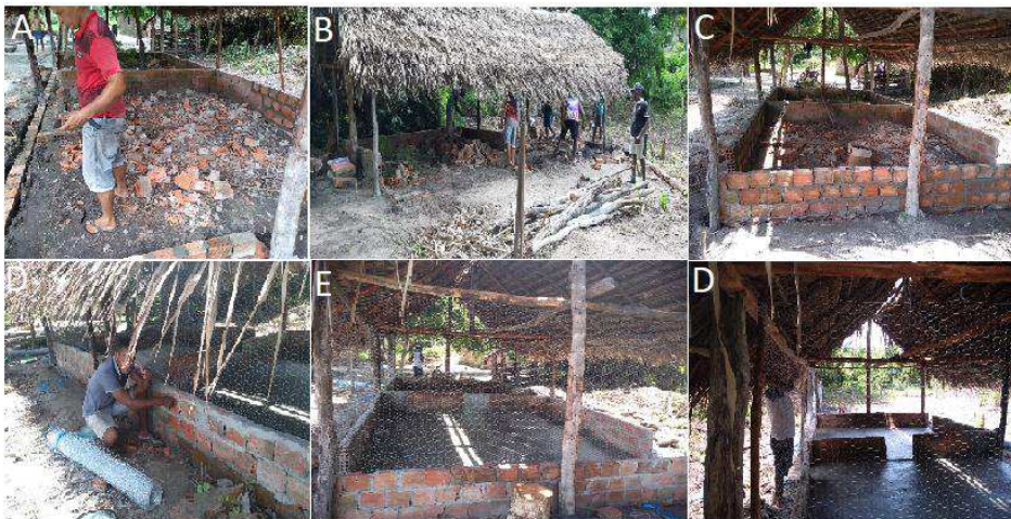
Figura 5 - A e C Galpão em processo de reforma. B Galpão antes da reforma. D Montagem da tela em todo galpão. E Tela finalizada. F Piso do galpão concluído.
