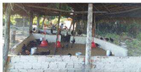
Figura 12: Estrutura do galpão. Fonte: Autores.
