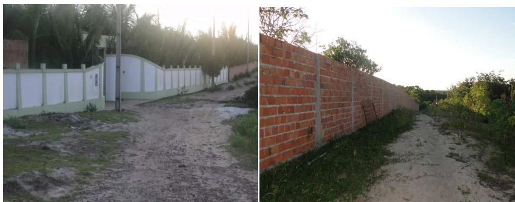
Fotos 15 e 16 - Os muros que se erguem
