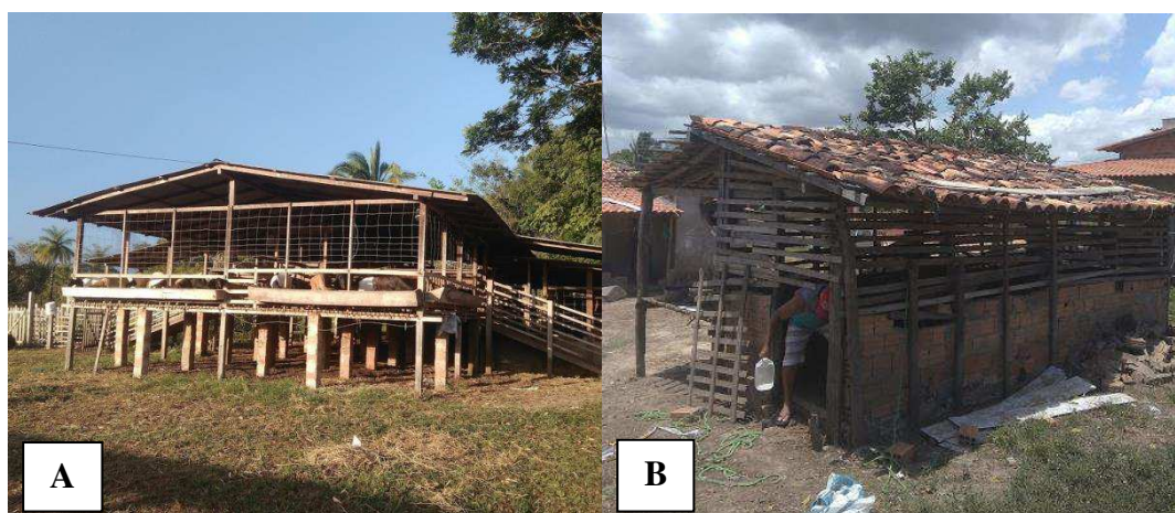
Figura 8 – Infraestrutura das instalações utilizadas por criadores de caprinos e ovinos em comunidades rurais do município de Matinha, Maranhão. A: Aprisco suspenso com piso de madeira; B: Aprisco com piso de chão batido.
