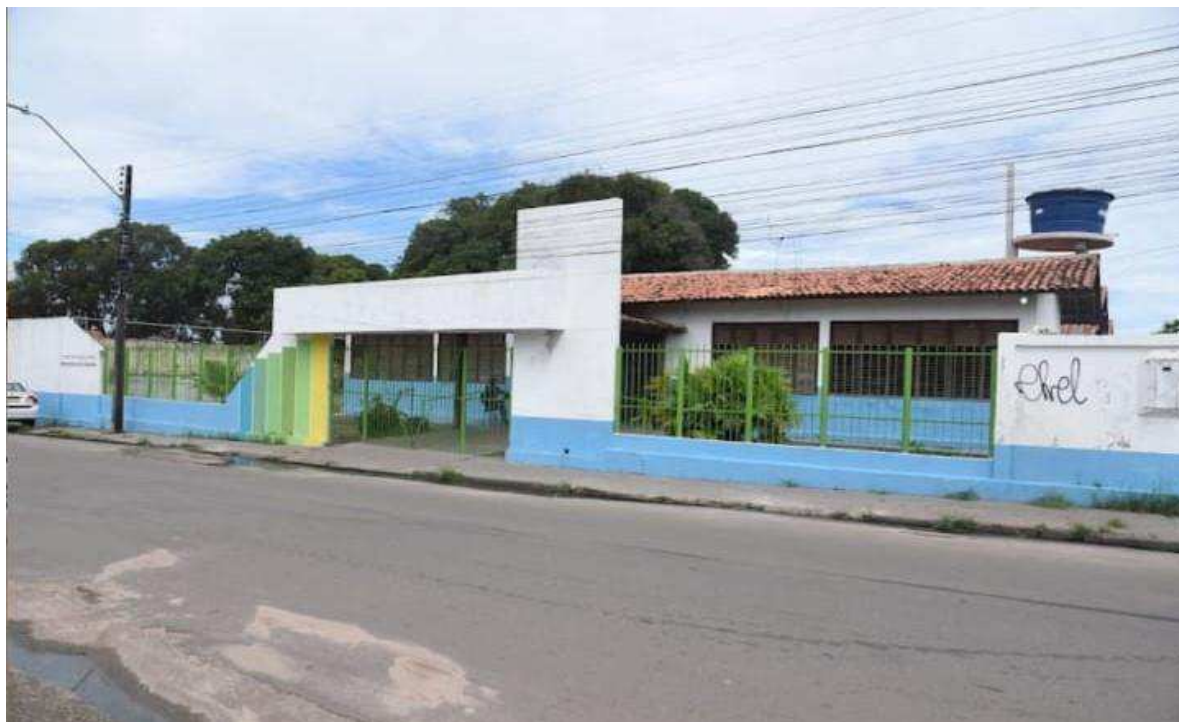
FIGURA 1: FAIXADA DE UNIDADE ESCOLAR 1° DE MAIO
