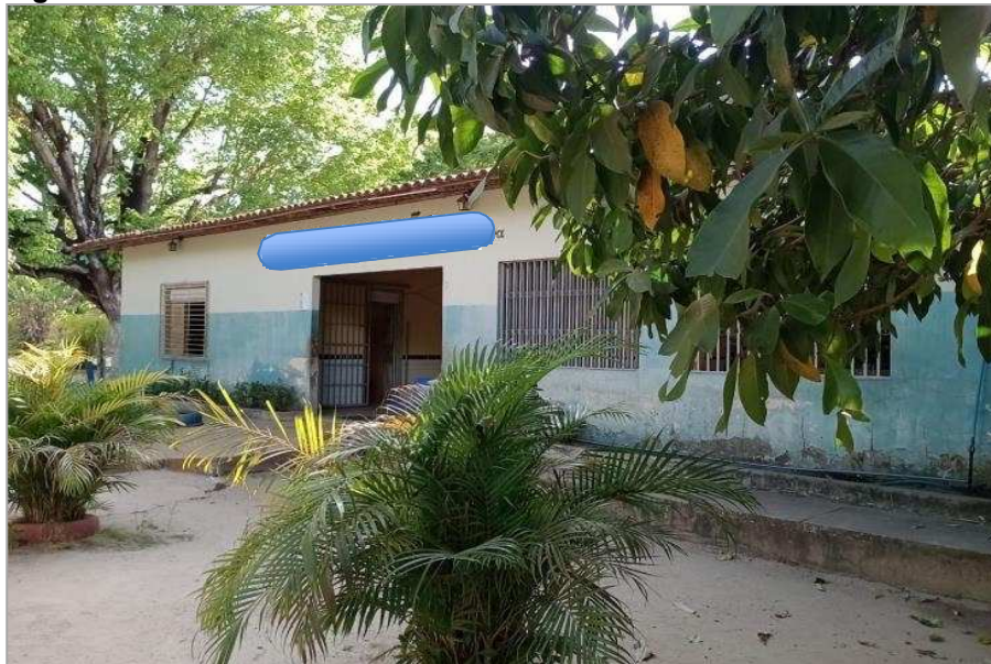
Figura 1 - Fachada da escola
