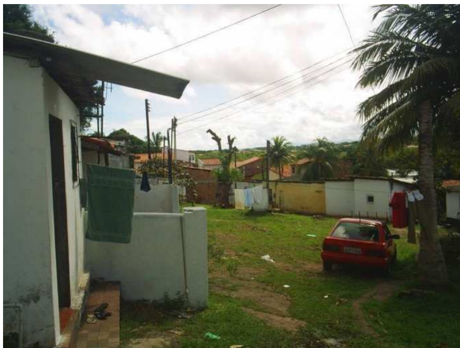
Foto 20 – Visão no sentido Sul-Norte - Vila Parga
