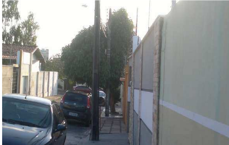
Figura 24 - Calçada na Rua 13
