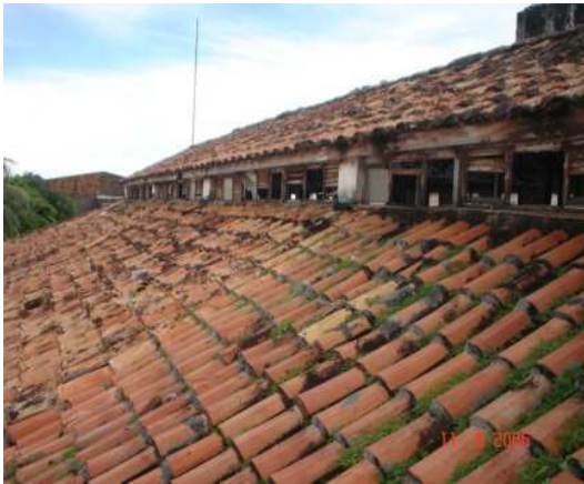
Foto 6- Detalhe do telhado- Fonte Jeovania Sá
