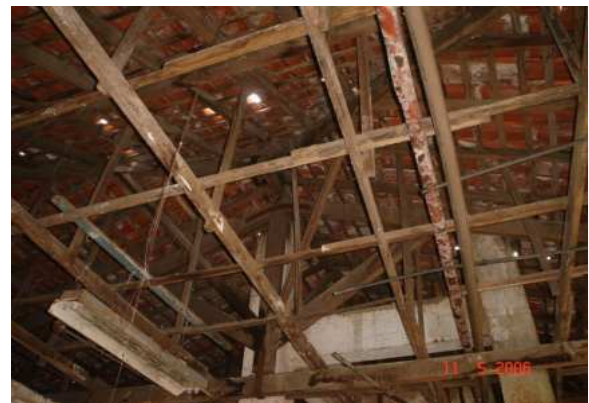
Foto 9- Detalhe do telhado. Fonte-Jeovania Sá
