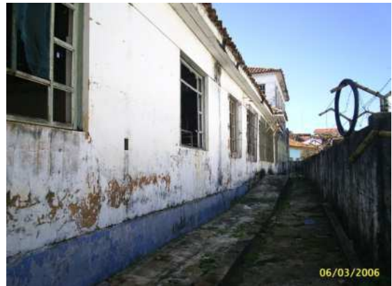
Foto 3- Vista da Fachada Lateral direita Fonte Jeovania Sá
