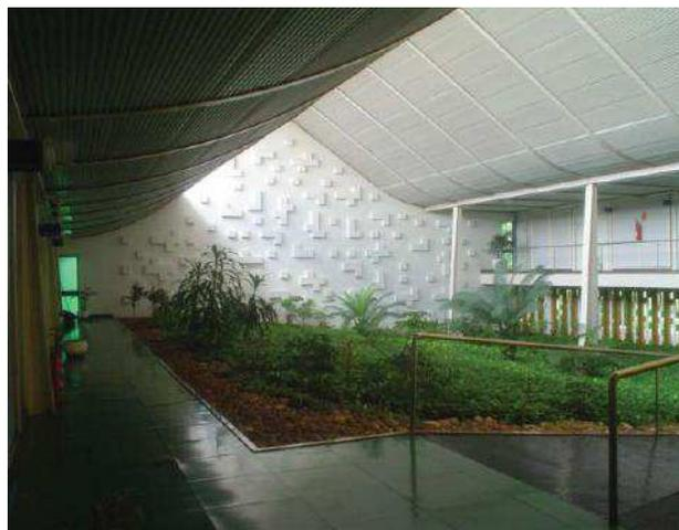
Figura 51: Tribunal de Contas da União (Cuiabá) - Jardim interno e abertura superior complementam a iluminação.
