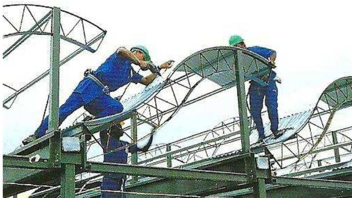
Figura 142: Montagem telha calandrada.
