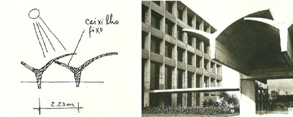
Figura 58: Distribuidora Brasileira de Veículos (DISBRAVE) - Esquema e imagem das vigas shed.
