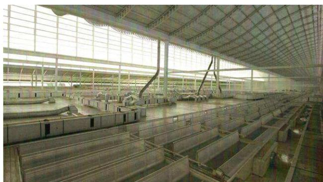
Figura 82: Hospital Sarah (Rio de Janeiro) - Sistema de forro em brises automatizados executado. Fonte: Latorraca; Risselada, 2010.
