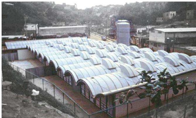
Figura 70: Creche do Bom Juá (Salvador) - Elementos pré-fabricados em argamassa armada.
