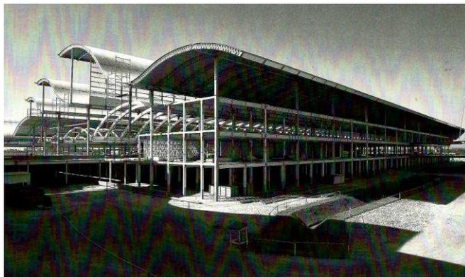
Figura 91: Sistema Estrutural - Sistema modular e apoio da cobertura.
