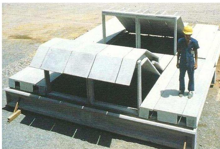
Figura 139: Protótipo de shed desenvolvido por Lelé para Hospital de Taguatinga.
