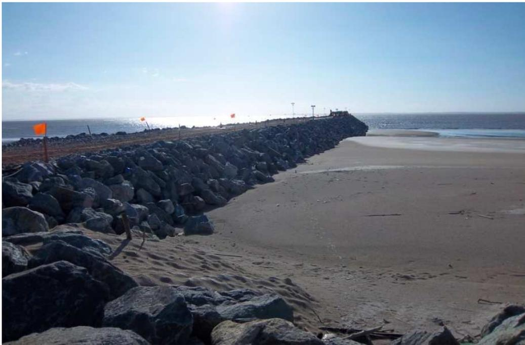
**Figura 36:** Construção do Espigão de Contenção Costeira já com 385m em junho de 2011.
