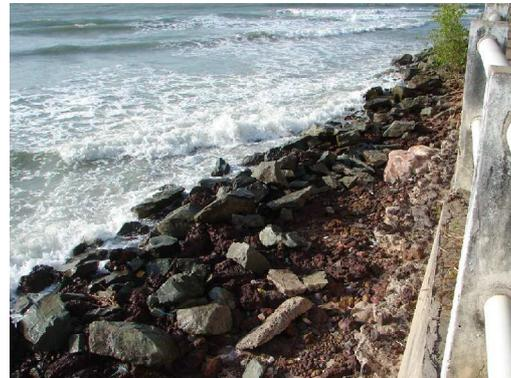
**Figura 21:** Obra de contenção da erosão na Ponta D´areia
