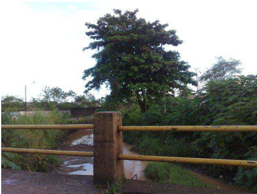
Figura 32 – Cinturão Verde, localizado no Planalto Alvorada.
