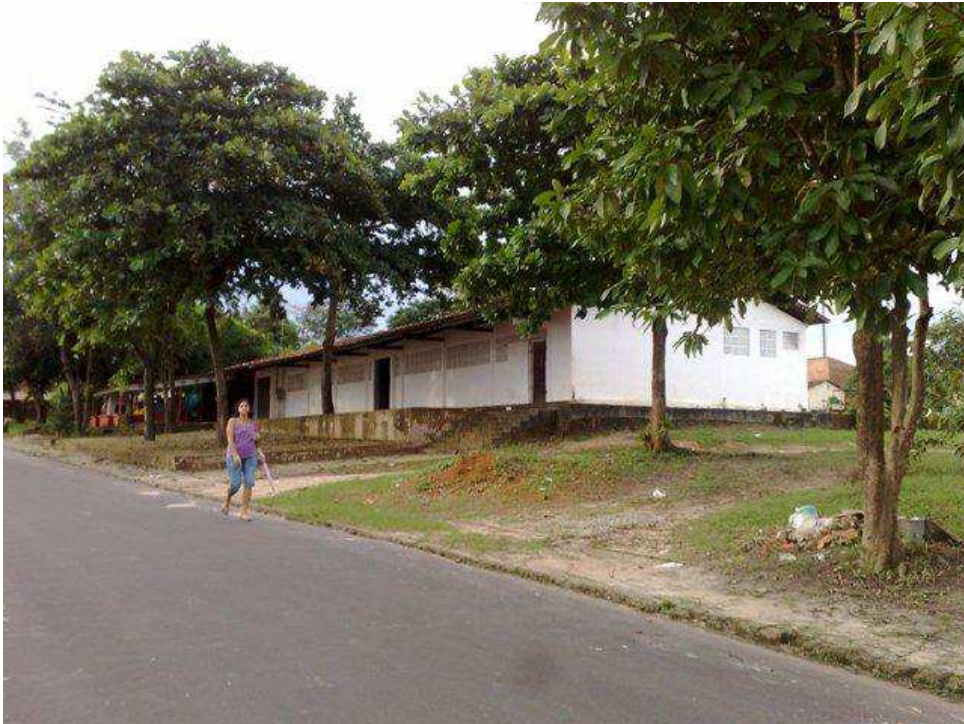
Figura 20 – Área livre 09, localizada no Cohatrac IV, em foco área construída existente, onde funcionava Posto de Saúde.
