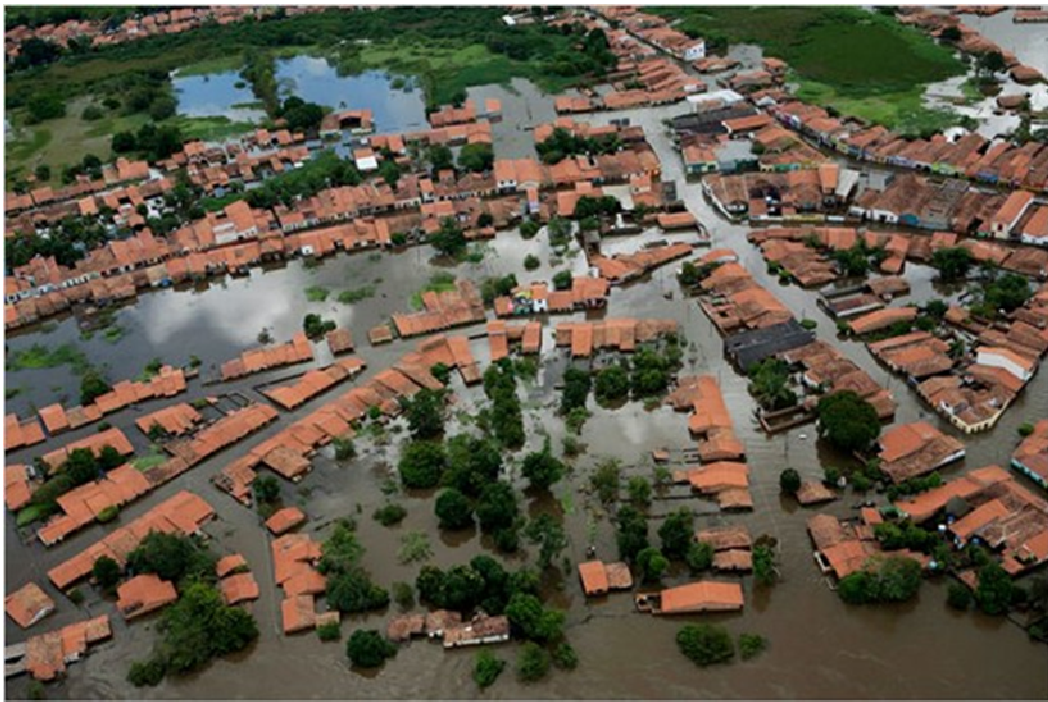
Figura 12: Inundação em Trizidela do Vale
