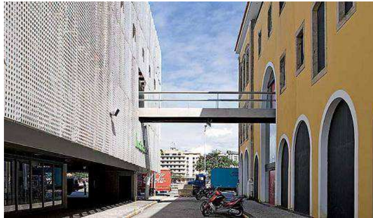
Figura 19: Edifício Garagem Paço Alfandega
