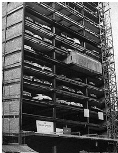
Figura 2: edifício Garagem América
