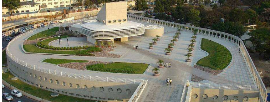
Figura 16: Edifício Garagem do Aeroporto de Congonhas
