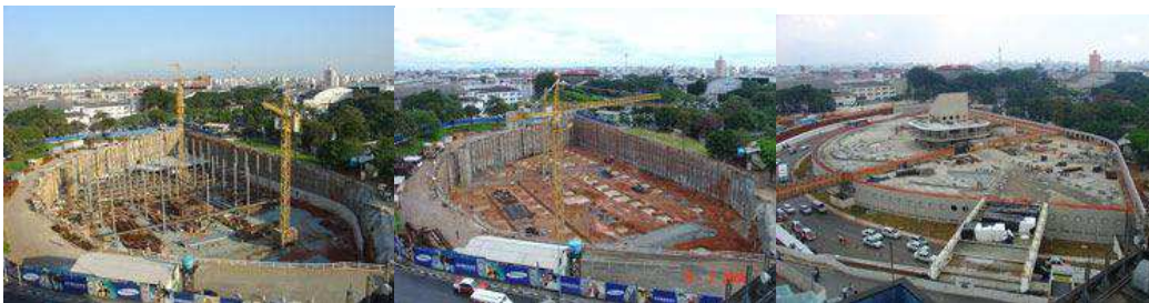
Figura 17: Construção Edifício Garagem do Aeroporto de Congonhas
