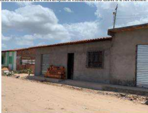
Figura 12: Casa de alvenaria
