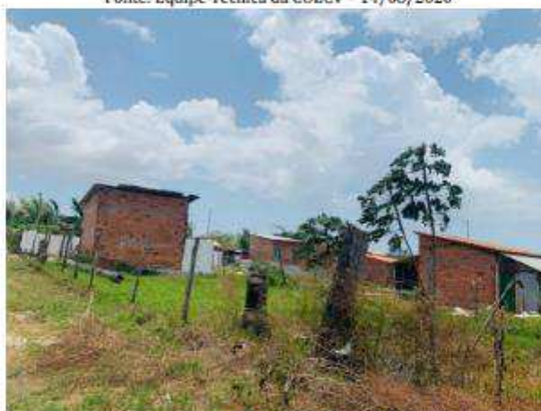
Figura 13: Casa de alvenaria
