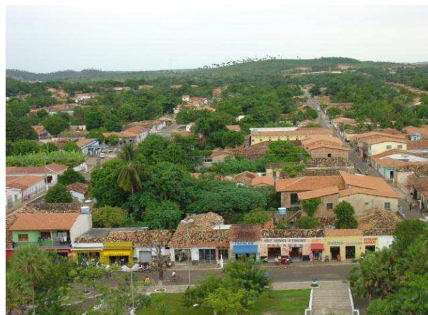
Figura 5 - Alinhamento dos lotes em Vargem Grande FONTE: Arquivos do ISO
