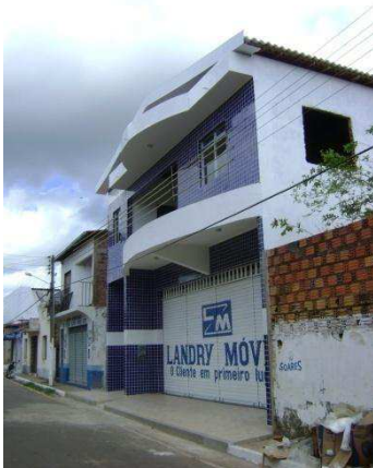
Figura 10 - Reforma para uso comercial em dois pavimentos FONTE: Fotografia de Izabel Oliveira Nascimento
