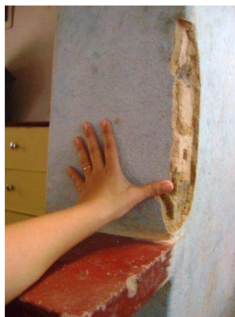
Figura 12 - Espessura da parede tomando como base a palma da mão (20 cm) FONTE: Fotografia de Izabel Oliveira Nascimento
