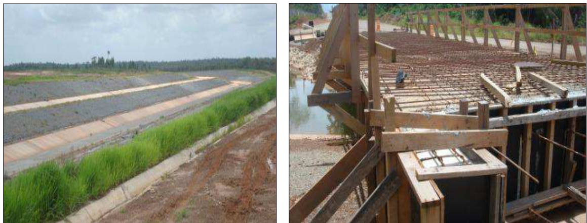
Figura 16- Canal de Drenagem, Proteção de Talude, Colchão Reno; Construção de Ponte, Obra paralisada.
