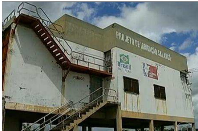
Figura 6- Sede do Projeto de Irrigação Salangô
