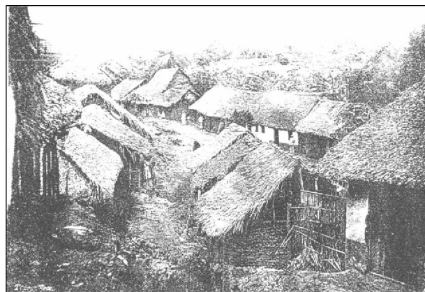
Fig. 6 – Vista da parte elevada sobre a baixada, trecho da rua por nós chamada Creme, terminando na rua Azul.
