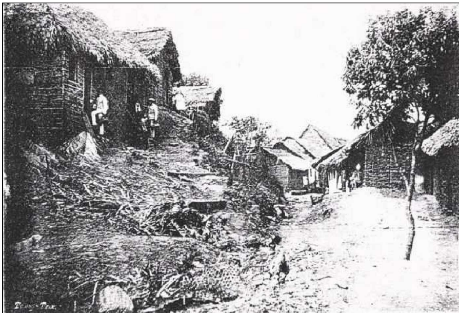
Figura 5: Vista de um trecho da passagem da parte acidentada para a baixada, em que se vêem dois empregados da Profilaxia Rural distribuindo pílulas de quinino e chenopódio aos moradores.*
