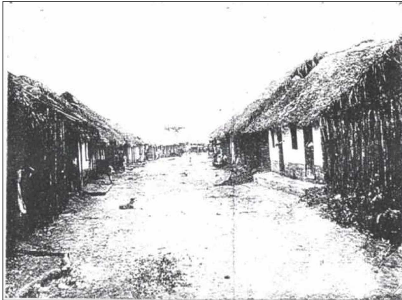
Figura 2: Trecho da Rua Codó de Cima, por nós chamada Rua Branca, depois de limpa.* Fonte: Ivaldo Ferreira
