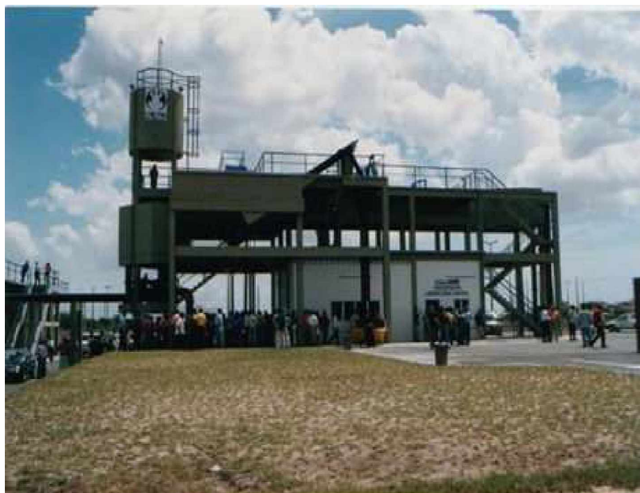
Figura 13: Estação de Tratamento de Esgoto do Bacanga Fonte: CAEMA
