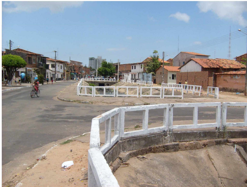
Figura 37: Rua que divide o canal, acesso ao bairro da Coréia, ao fundo, primeira parte da vala.
