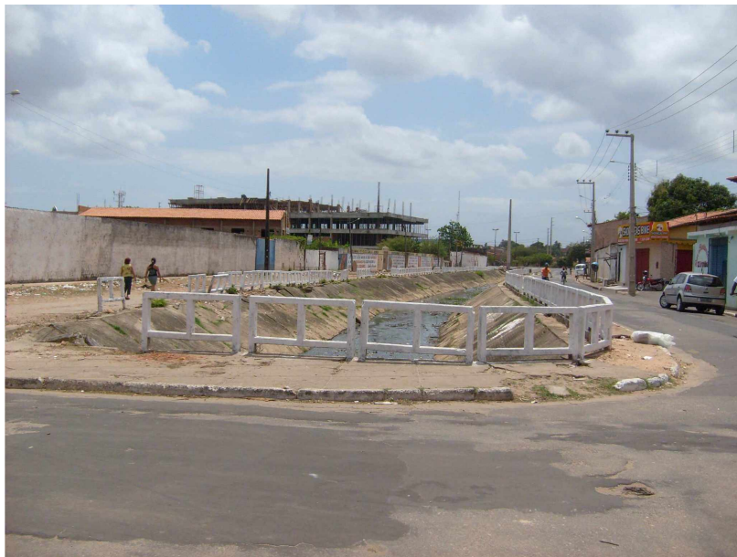
Figura 38: Vista da segunda parte da vala, ao fundo Fórum Astolfo Costa em construção.
