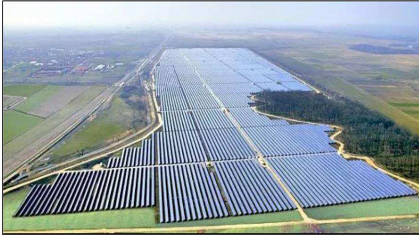
FIGURA 1: USINA DE ENERGIA FOTOVOLTAICA
