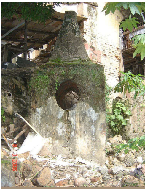
Figura 3 - Torres de acesso às galerias da Fonte das Pedras Fonte: a autora
