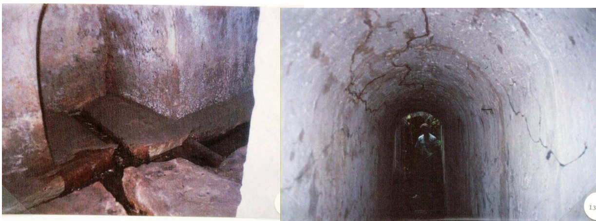
Figura 4 - Galerias da Fonte das Pedras Fonte: IPHAN
