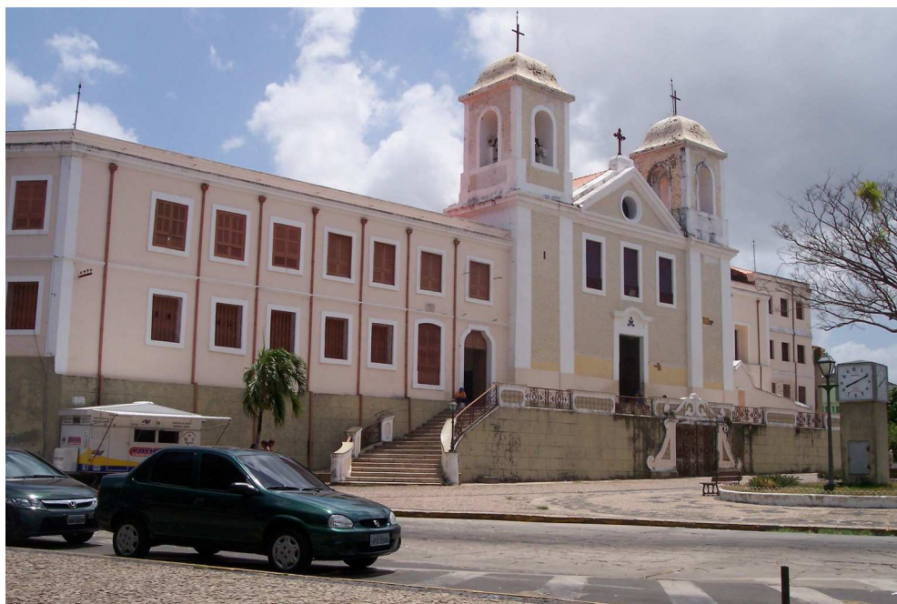
Figura 50 – Fachada atual da Igreja e Convento do Carmo, 2007.
