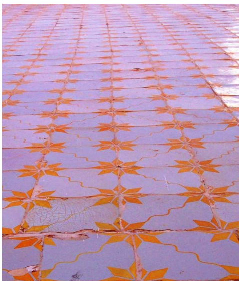
Figura 27 – Azulejos da fachada da Igreja do Carmo.
