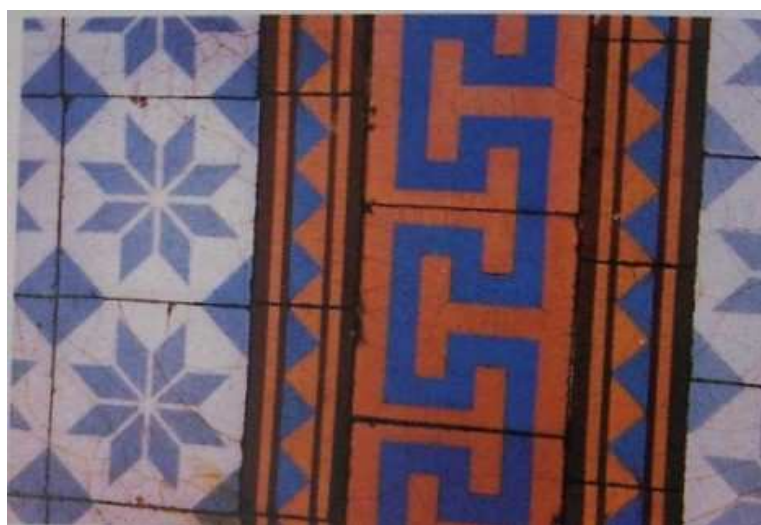
Figura 35 – Igreja Nossa Senhora do Carmo. Detalhe do piso parte externa P.P.P.8 e P.P.P.6, 2006.
