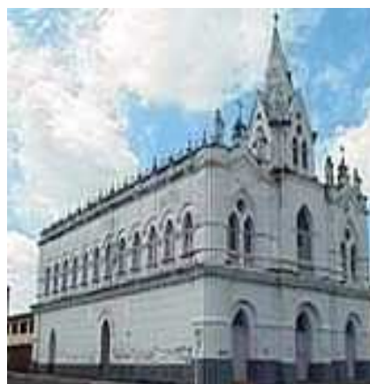
Figura 14 – Igreja dos Remédios, 2007.
