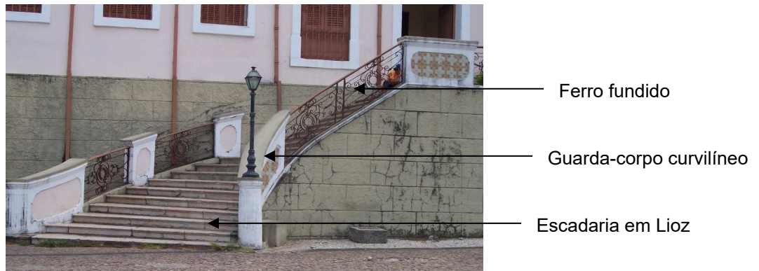
Figura 53 – Detalhe da escadaria curvilínea e guarda-corpo
