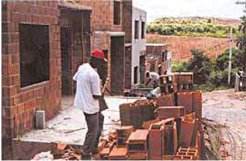
Figura 2: Trabalhos de mutirões Fonte: PORTAL SESCSP (2007)
