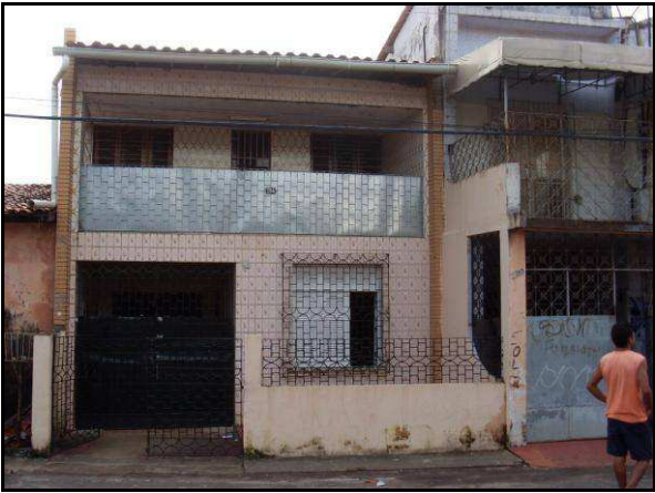
Entrada principal da casa
