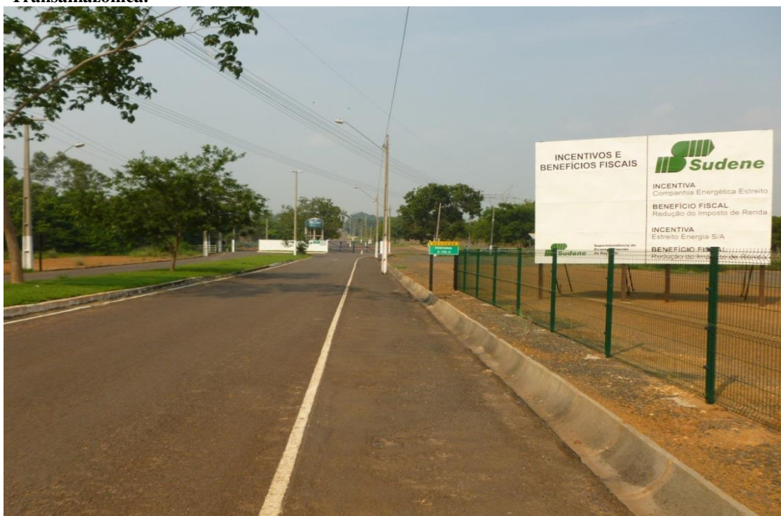
FIGURA 8: Entrada da UHE-Estreito na cidade de Estreito, acesso pela rodovia BR 230, Transamazônica.
