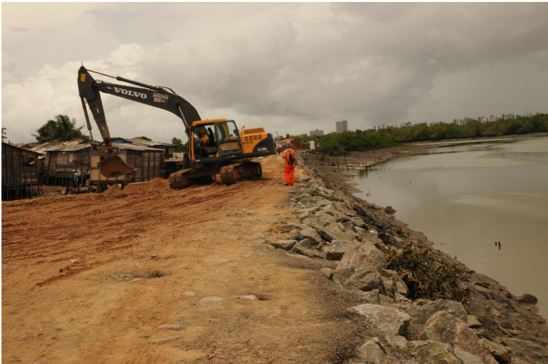
Foto 3 - Construção da ponte quarto centenário – Obras do PAC Rio Anil em São Luís.
