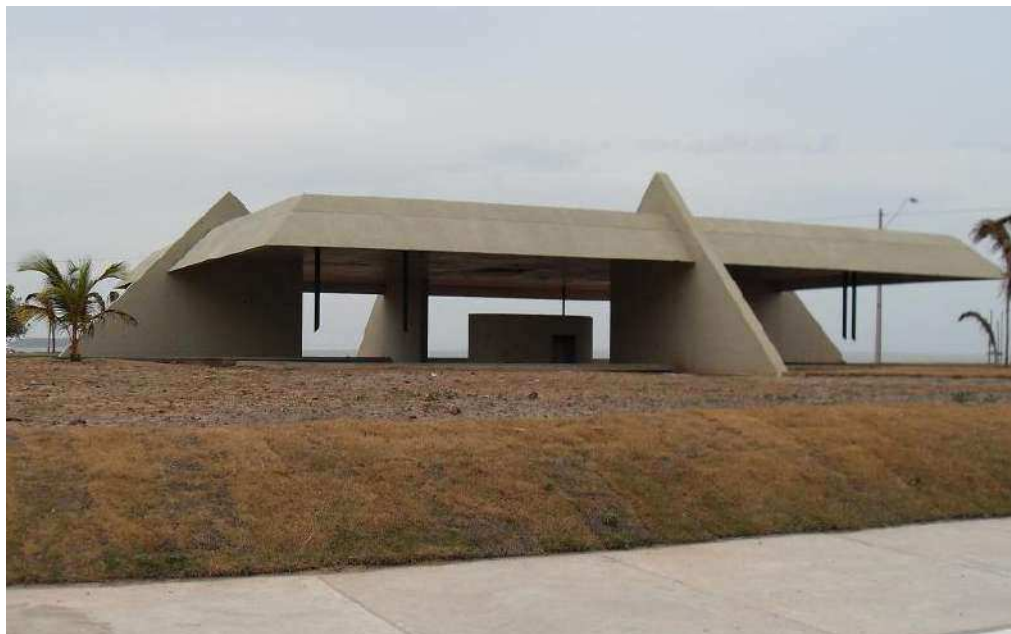
Fig. 3 - Memorial Bandeira Tribuzzi em 2009. Frente de um dos três prédios que compõem a obra. São Luís – Ma. Fonte: Santos (2009).
