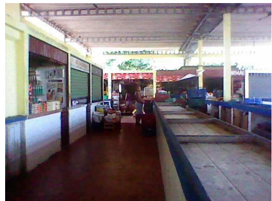
Figura 19: interior do Mercado da Macaúba Fonte: própria, 2010
