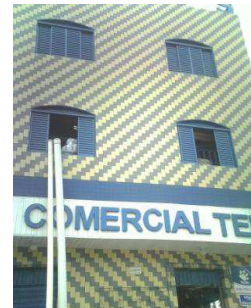
Figura 40. Edificação de 3 pavimentos Fonte: própria, 2011
