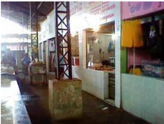
Figura 62: Estrutura dos pilares
