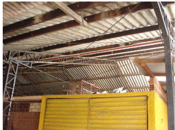
Figura 63: Estrutura do telhado
