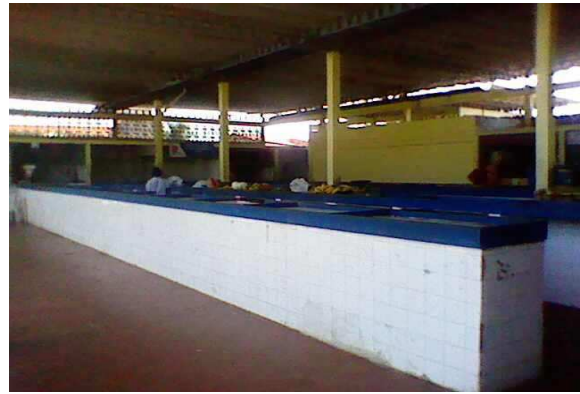
Figura 21: interior do Mercado da Macaúba Fonte: própria, 2010
