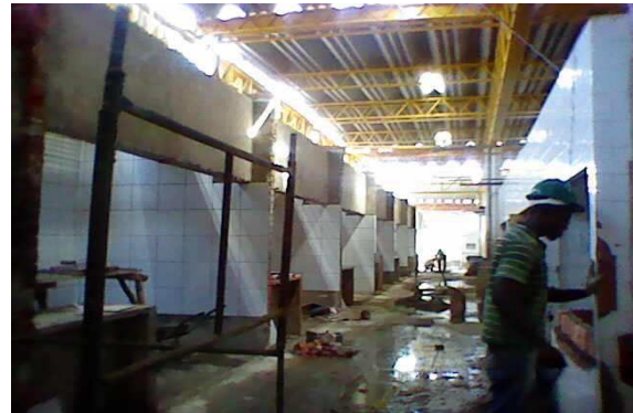
Figura 37: reforma no Mercado da Liberdade Fonte: própria, 2010
