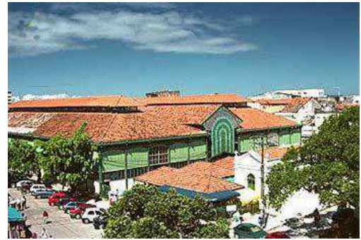
Figura 04. Mercado de São José, no Recife Fonte: piratasdapraia.com . Acesso em: Nov.2010.
