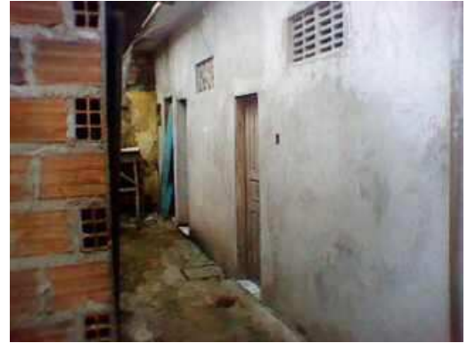
Figura 58: Banheiros depois da reforma Fonte: própria, 2011
