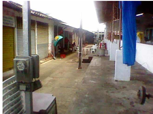
Figura 27: interior do Mercado da V. Palmeira Fonte: própria, 2010
