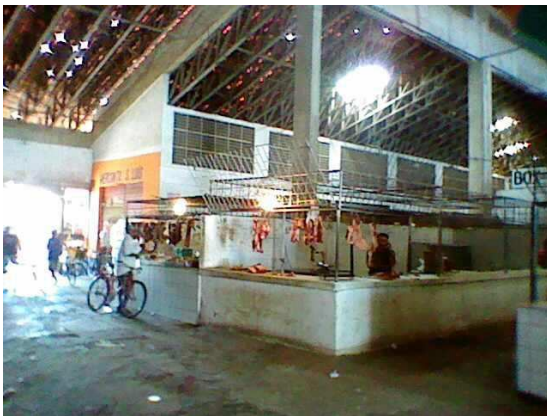
Figura 30: estrutura do Mercado da C. Operária Fonte: própria, 2010
