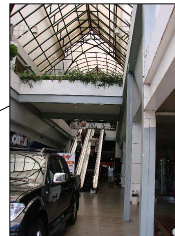
IMAGEM DA CIRCULAÇÃO VERTICAL - ACESSO AO MEZANINO (PVTO. SOBRELOJA)
