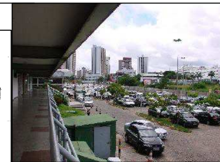
IMAGEM DO ESTACIONAMENTO LOCALIZADO NOS FUNDOS DA EDIFICAÇÃO
