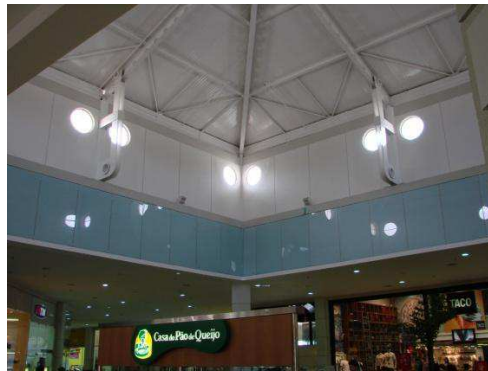
Foto 22: aberturas que permitem a passagem de iluminação natural no SLZS. Fonte: acervo pessoal.
