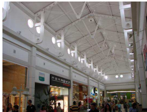
Fotos 23: aberturas que permitem a passagem de iluminação natural no SLZS. Fonte: acervo pessoal.
