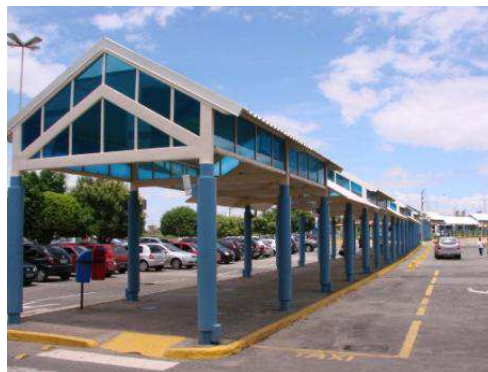
Foto 24: rampa para acesso de pessoas com mobilidade reduzida no SLZS.
