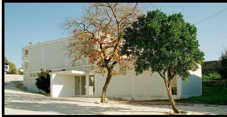
Foto 13 - Fachada do Centro de Dança do Porto, em Portugal
