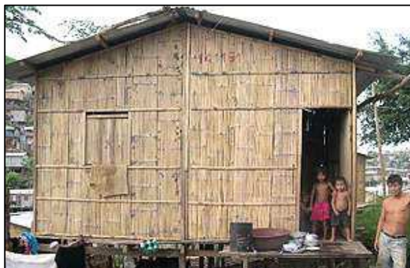
Figura 4 – Habitação com Bambu, projeto desenvolvido pela Fundação Viviendas Hogar de Cristo, ONG jesuíta equatoriana. Equador. 4
