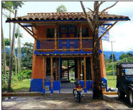
Figura 3 – Habitação em Bambu, Habitação de interesse social, em bambu, feita pelo arquiteto colombiano Simon Vélez. Colômbia. 3
