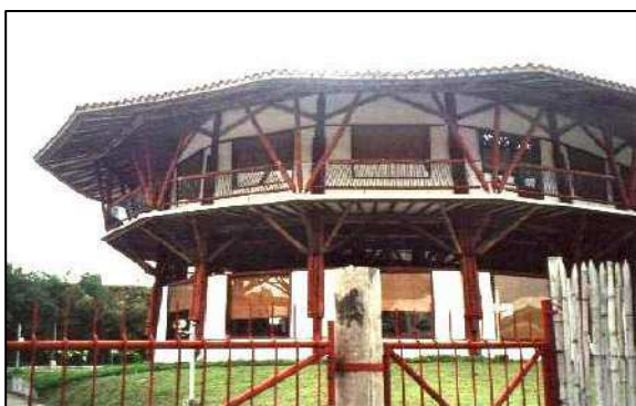
Figura 18 - Edifício sede da CARDER, Corporación Autónoma de Risalda, com 6.524 m 2 construídos de guadua. Obra do Arq. Simon Vélez. (Fonte: Foto de Anelizabeth Alves Teixeira, Colômbia, dezembro de 2005).
