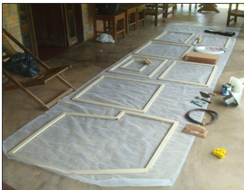
Figura 09. Moldes preparados para a confecção das placas.
