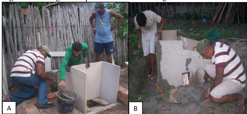
Figura 15. Colagem das placas com cimento e água.
