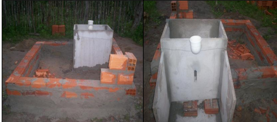
Figura 16. Secagem do chumbamento das placas.
